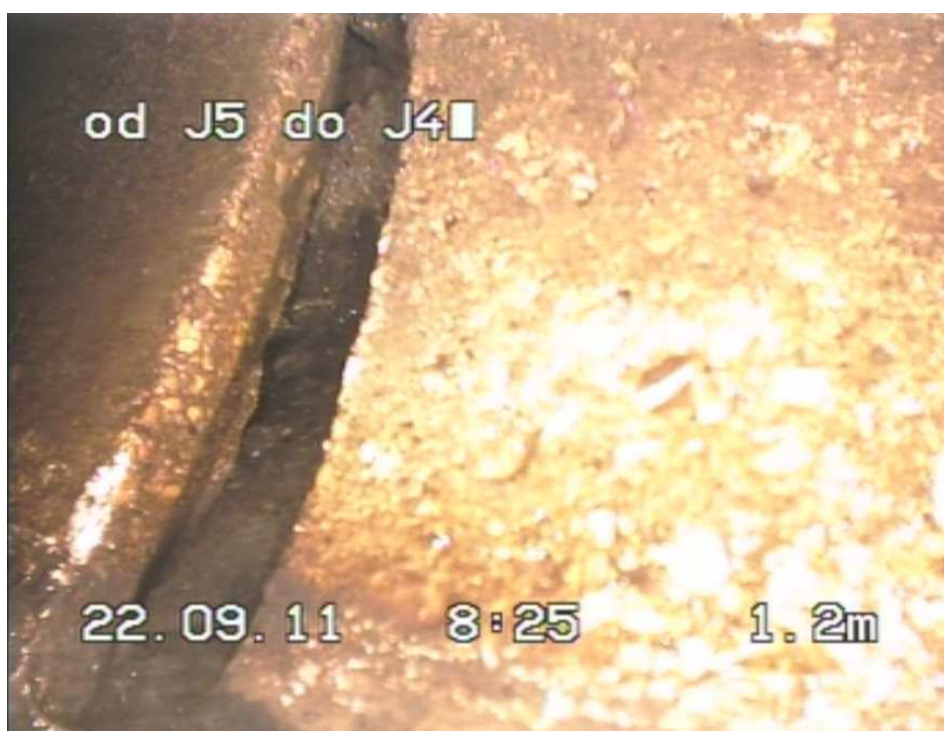
Slika 10: Pregled kanalizacije s kamero (september 2011).
