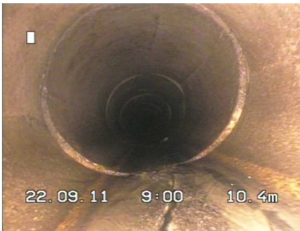
Slika 9: Pregled kanalizacije s kamero (september 2011).
