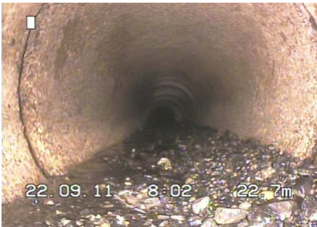
Slika 11: Pregled kanalizacije s kamero (september 2011).
