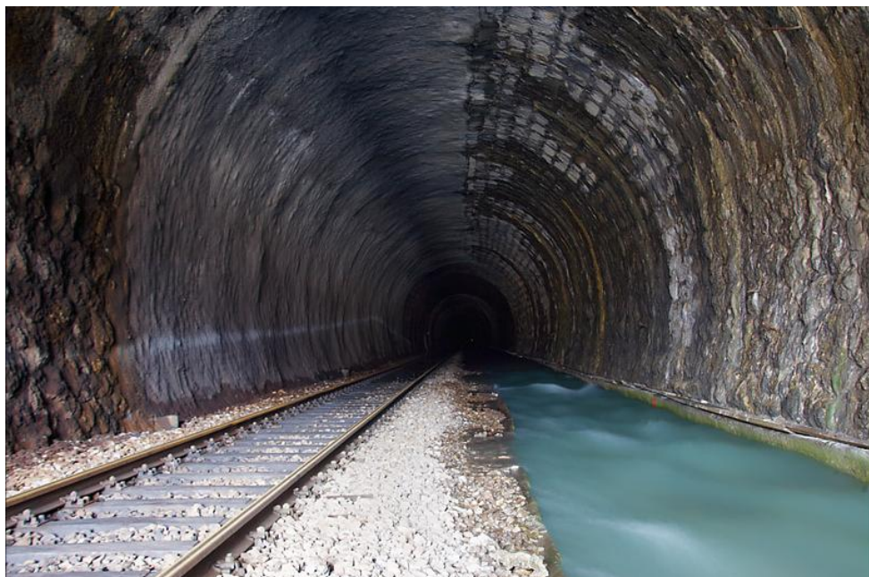
Slika 8: Bohinjski predor (vir: [49])
