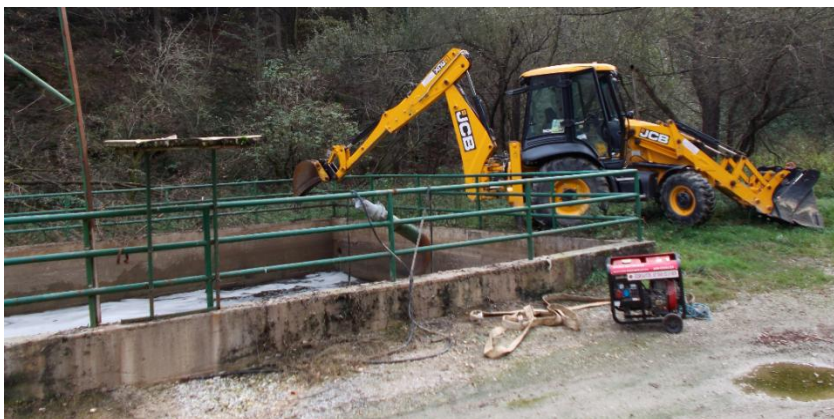
Slika 31: Prikaz mešanja zbiralnika izcedne vode s pomočjo zadnje kible rovokopača (lasten posnetek)
