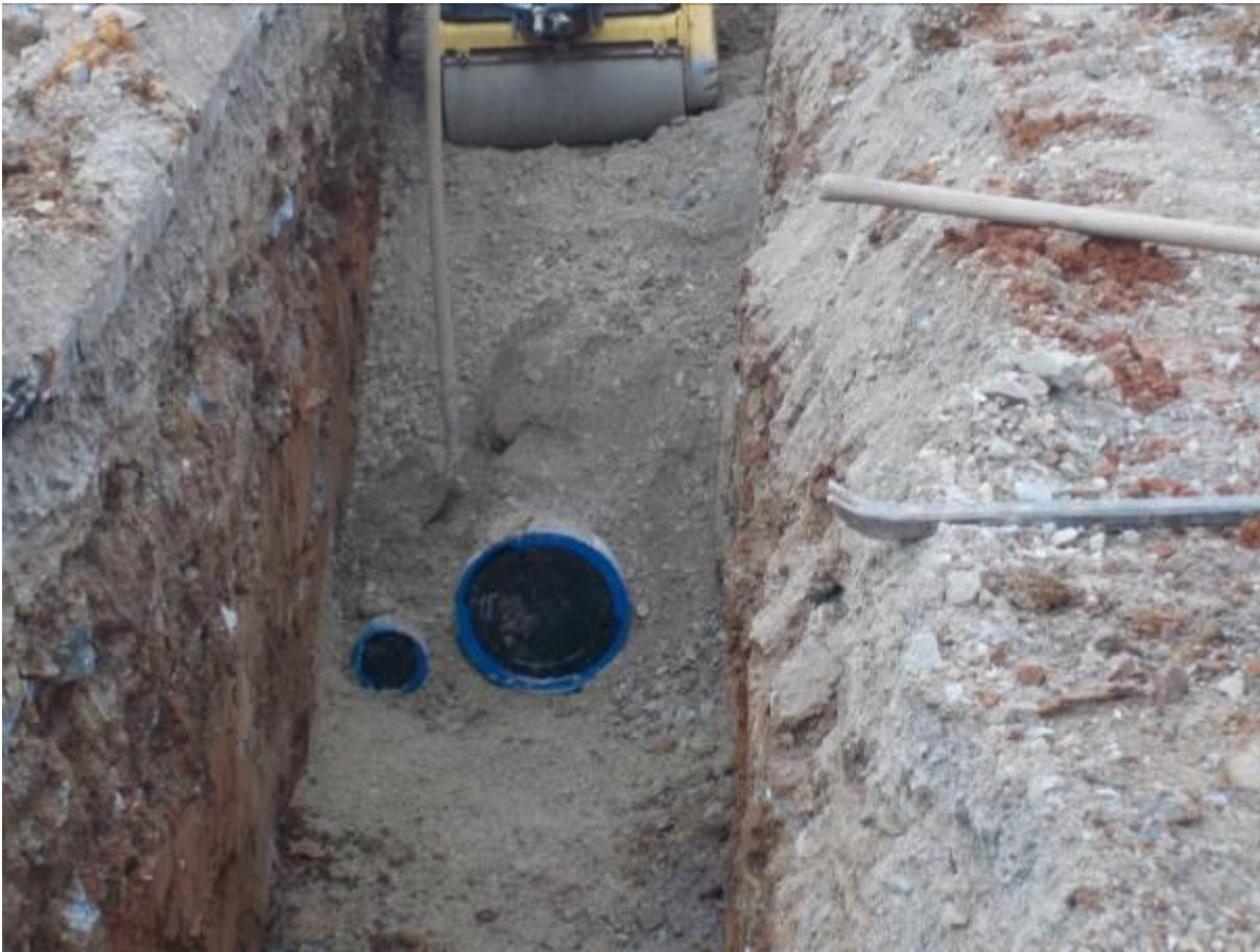
Slika 9: Zasipanje in zgoščevanje obsipa in zasipa cevi, [lasten arhiv]
