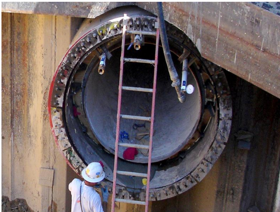
Slika 59: Injektiranje vmesnega prostora med potisno in vstavljenjo cevjo, [35]
