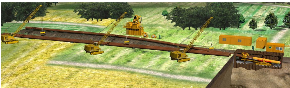
Slika 60: Prikaz gradbišča za vgrajevanje cevovoda po tehnologiji DIRECT PIPE®, [29]
