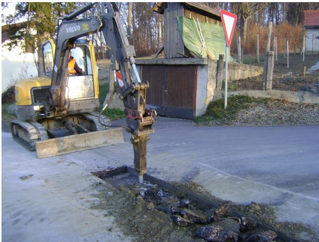
Slika 6: Rušenje voziščne konstrukcije, [lasten arhiv]
