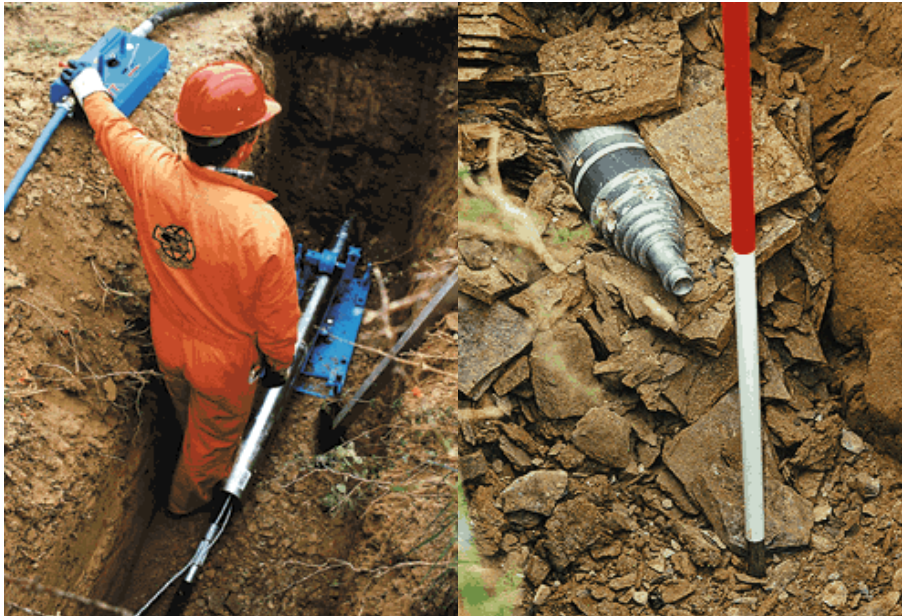
Slika 18: Prikaz vstopne in izstopne gradbene jame, [10]
