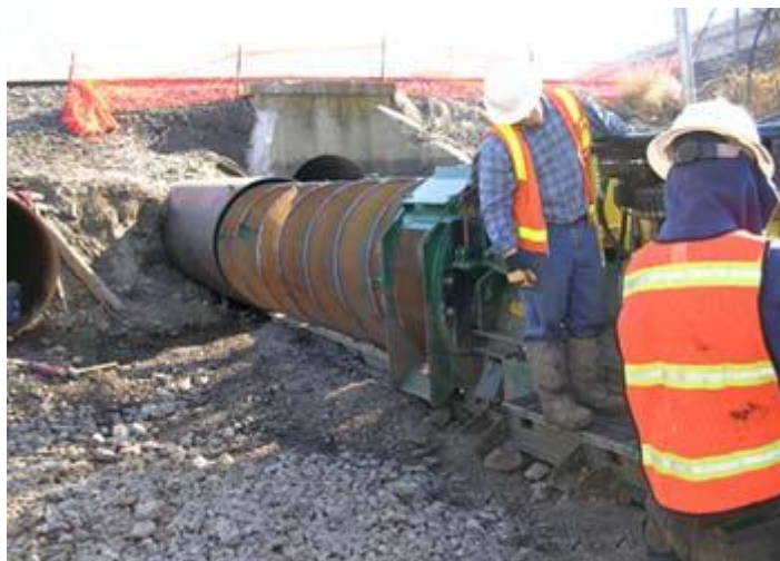
Slika 26: Polžnica pritrjena na vrtalni stroj, [33]
