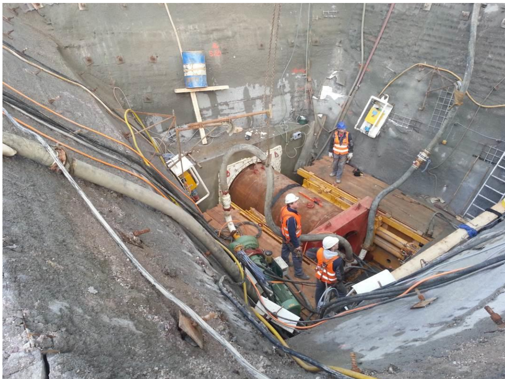
Slika 53: Potisk MTBM skozi vhodno tesnilo, [34]
