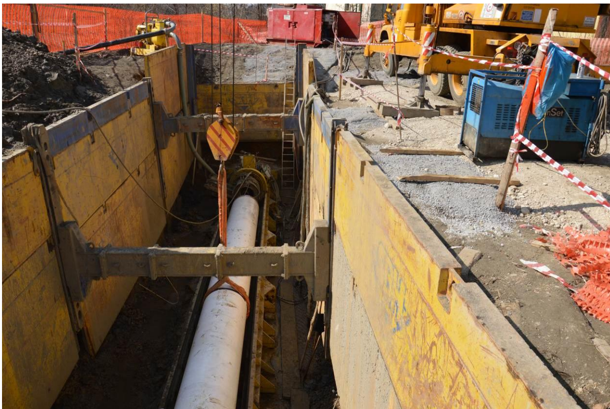
Slika 28: Vstopna gradbena jama, [lasten arhiv]
