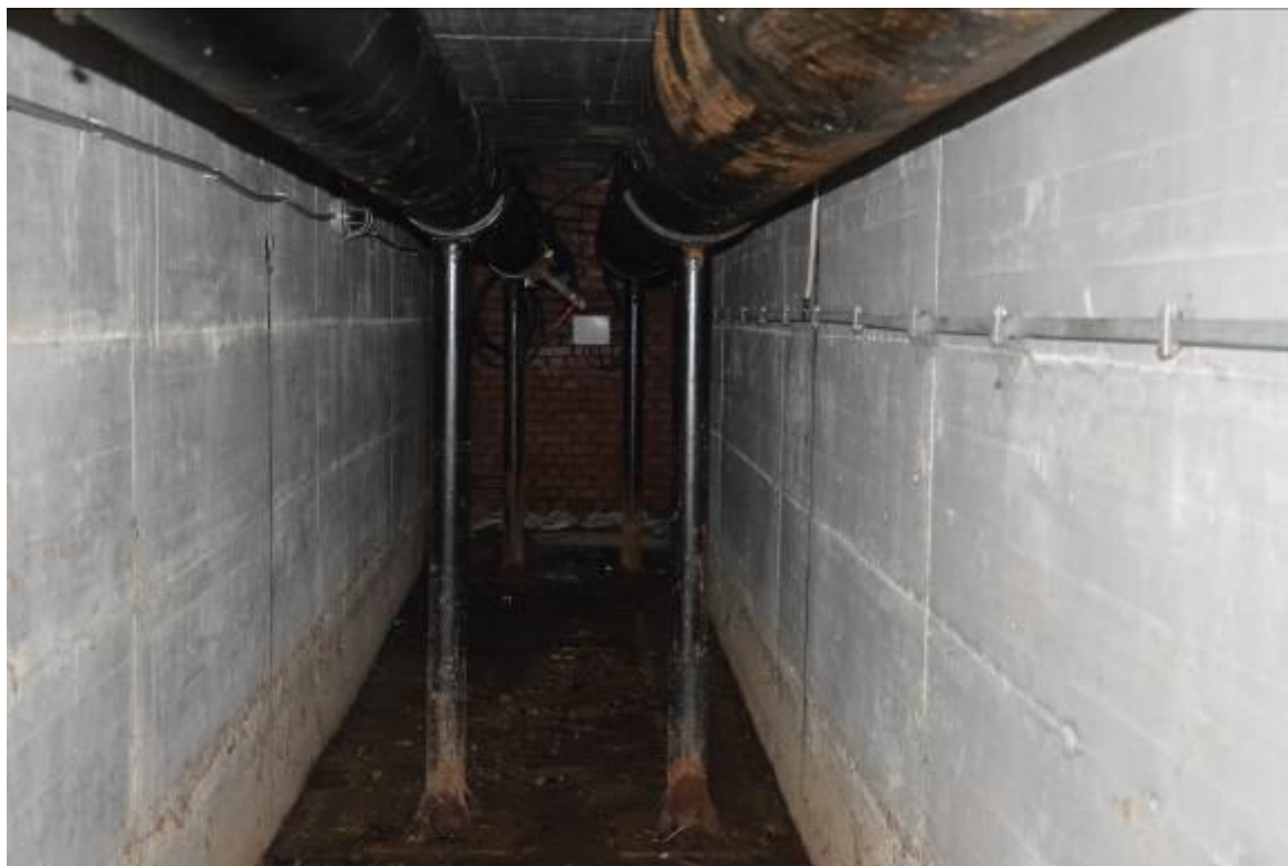
Slika 15: Podpiranje cevovoda JE 500 mm, [lasten arhiv]
