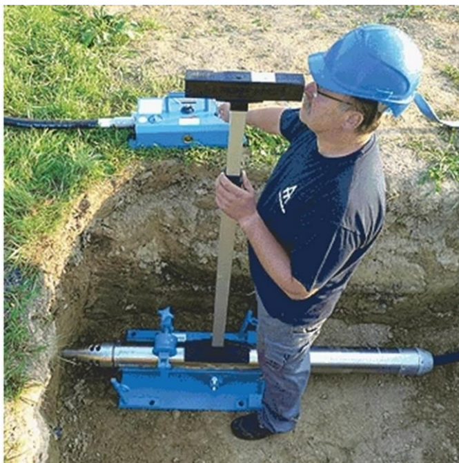
Slika 17: Niveliranje pnevmatske igle v vstopni gradbeni jami, [9]
