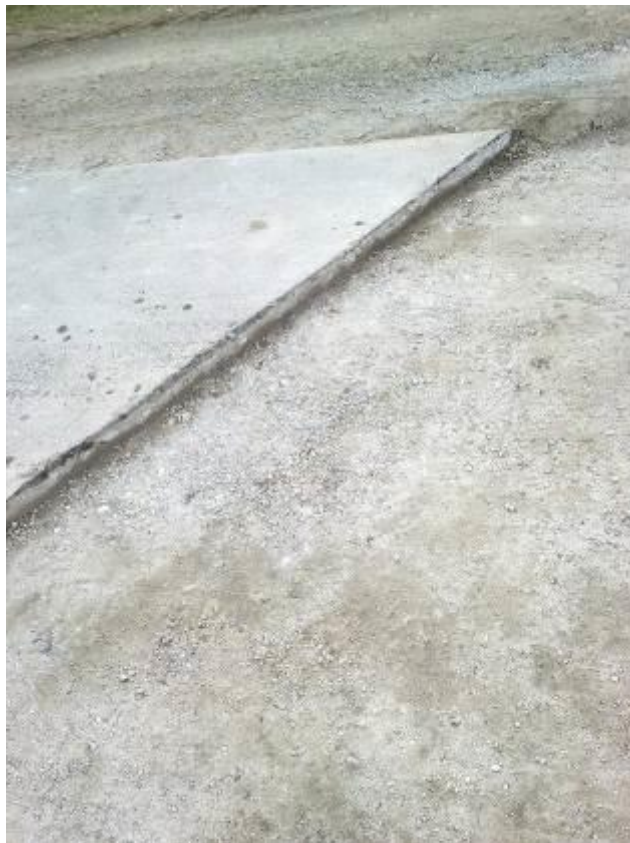
Slika 10: Odrezan in očiščen rob asfalta, [[lasten arhiv]
