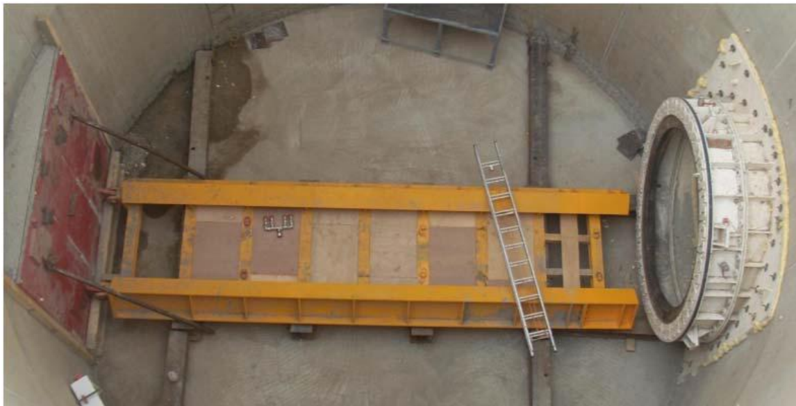
Slika 54: Vodilo za potisno enoto, oporna stena in vhodno tesnilo, [lasten arhiv]
