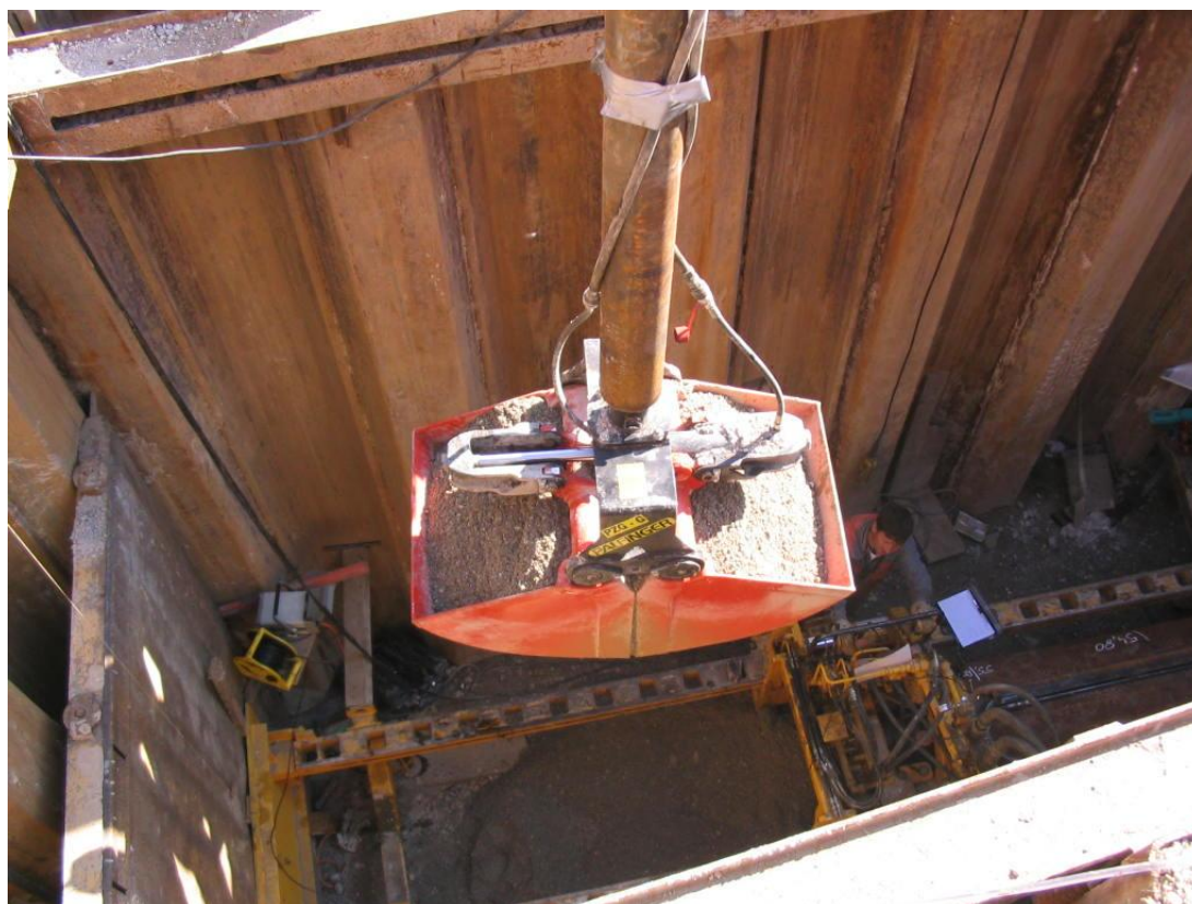
Slika 27: Odstranjevanje zemlje iz gradbene jame z grabilcem, [lasten arhiv]
