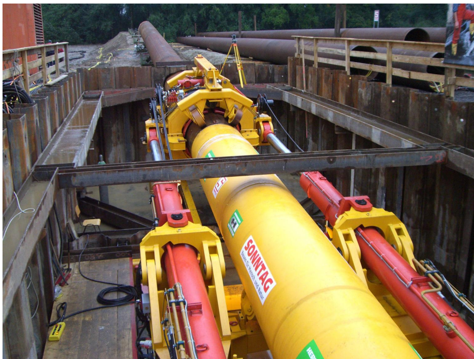
Slika 62: Vstopna gradbena jama med potiskom MTBM s pomočjo potiskalca cevi (Angl.: Pipe Thruster); v ozadju prvi cevni segmentu postavljen na progo z valji, [29]
