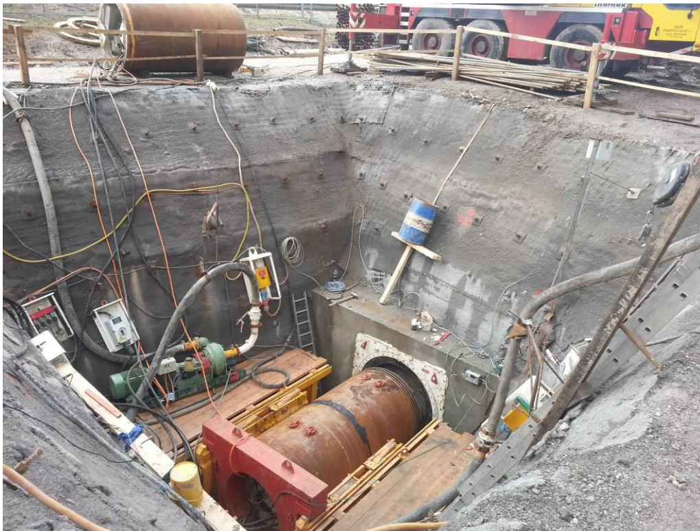
Slika 52: Spust MTBM v vstopno jamo, [34]
