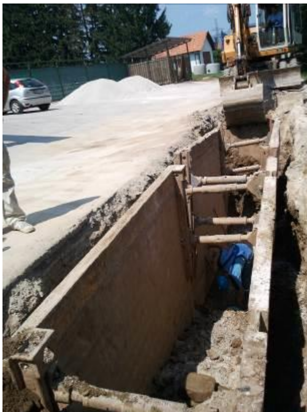
Slika 7: Razpiranje jarka, [lasten arhiv]
