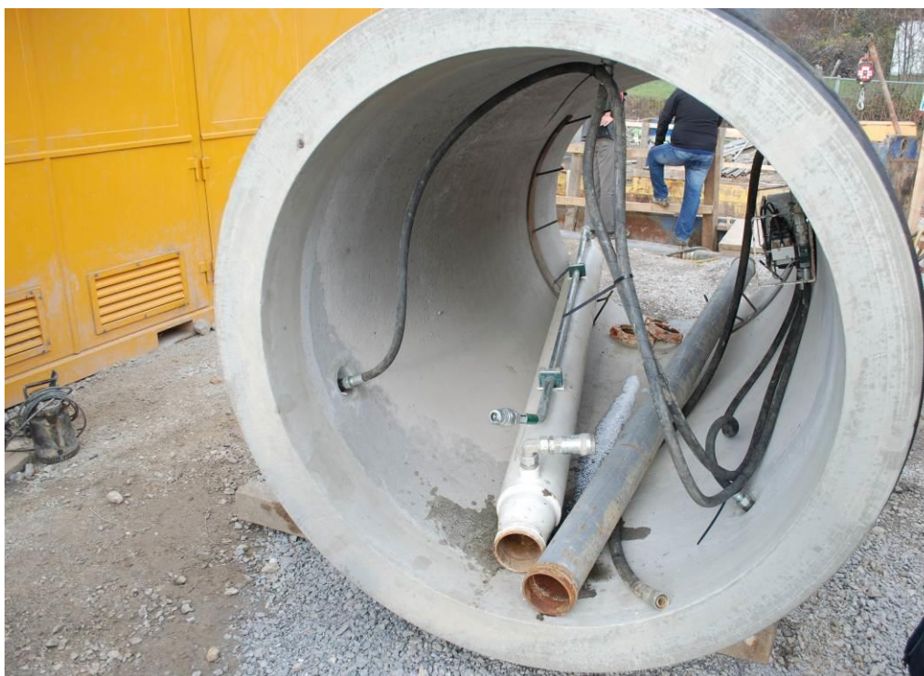
Slika 48: AB potisna cev pripravljena za spust v gradbeno jamo, [lasten arhiv]
