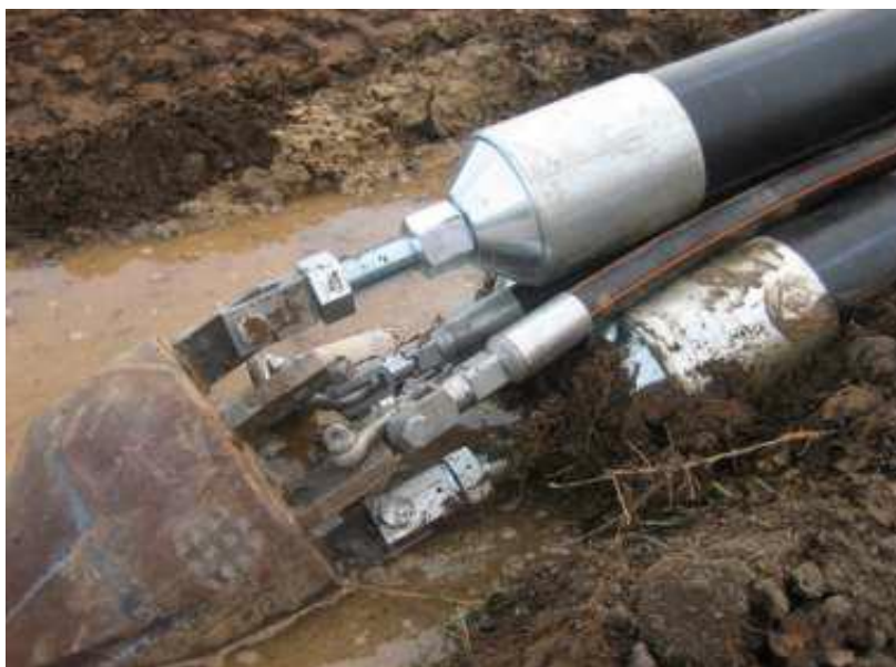
Slika 45: Uvlačenje cevi, [16]
