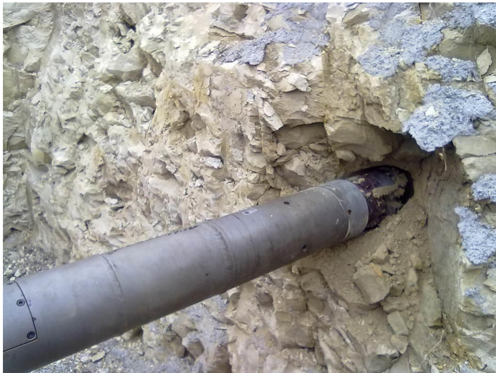
Slika 24: Vrtanje pilotne vrtine, [14]
