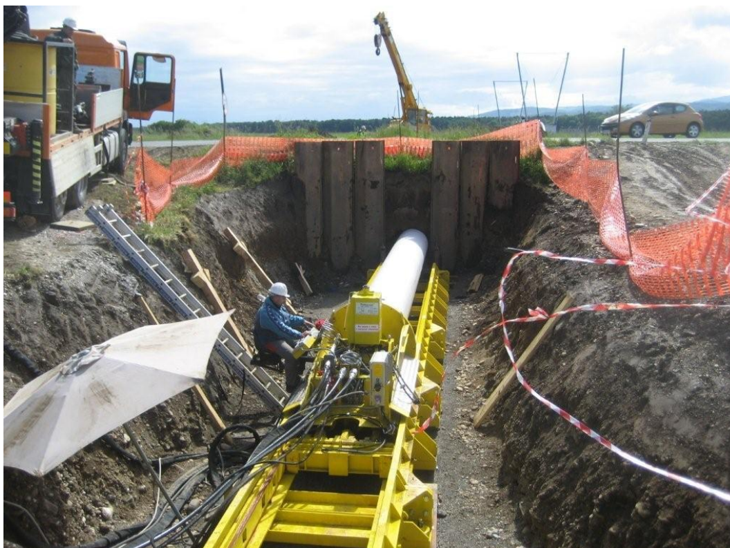
Slika 23: Usmerjeno vrtanje z optičnim vodenjem, [14]
