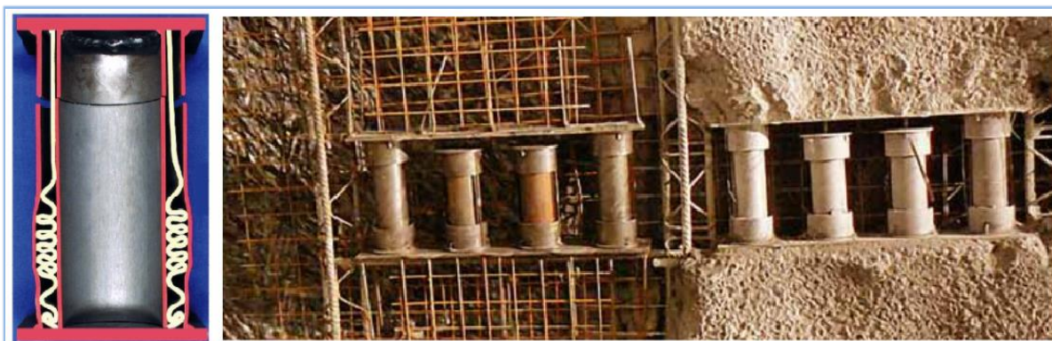
Slika 2.8: Primer popustljivih elementov (LSC – Lining Stress Controller) (prirejeno po DSI, 2014: str 5 in Schubert et al., 1999: str 337).
