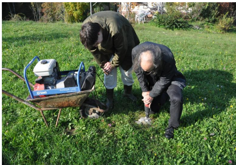
Slika 5.8: Stabilizacija kontrolnih točk
