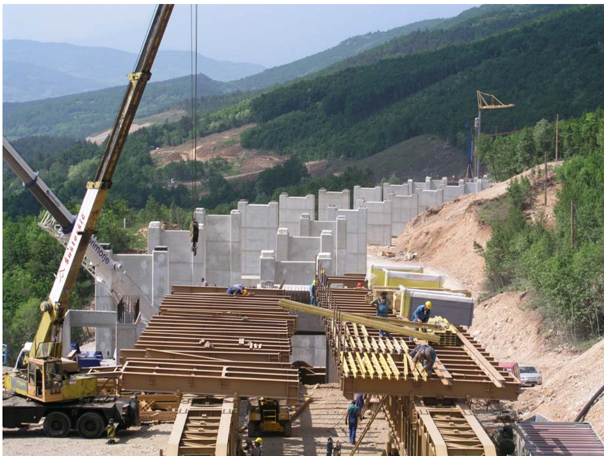
Slika 9: Montaža POS
