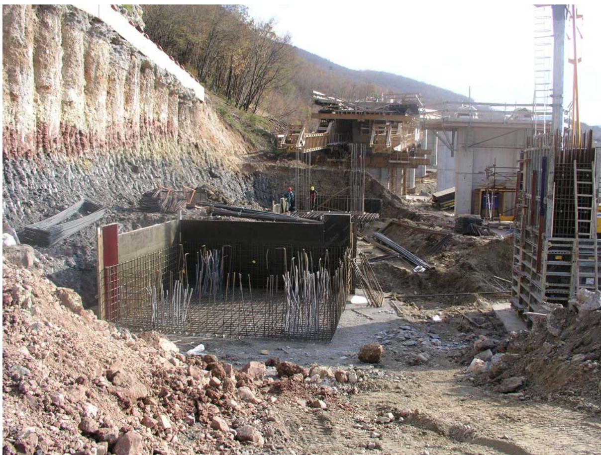
Slika 7: Izvedba temeljne blazine
