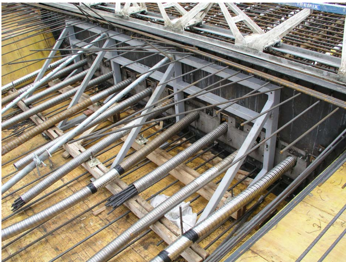
Slika 16: Čelna zapora z armaturo in kabli za naslednjo fazo
