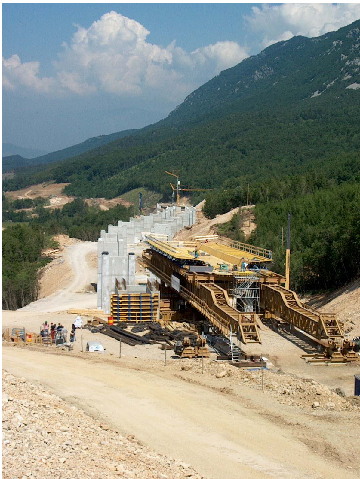
Slika 11: Izvedba prve kampade zgornje konstrukcije
