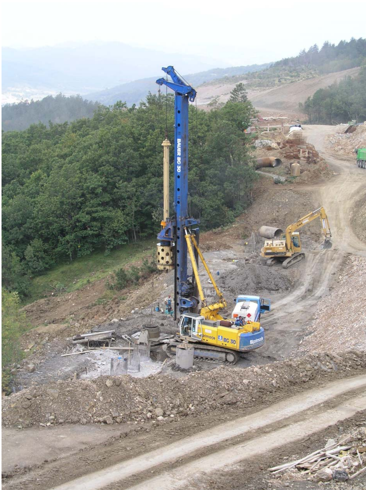
Slika 5: Izvedba pilotiranja s strojem BAUER BG 30
