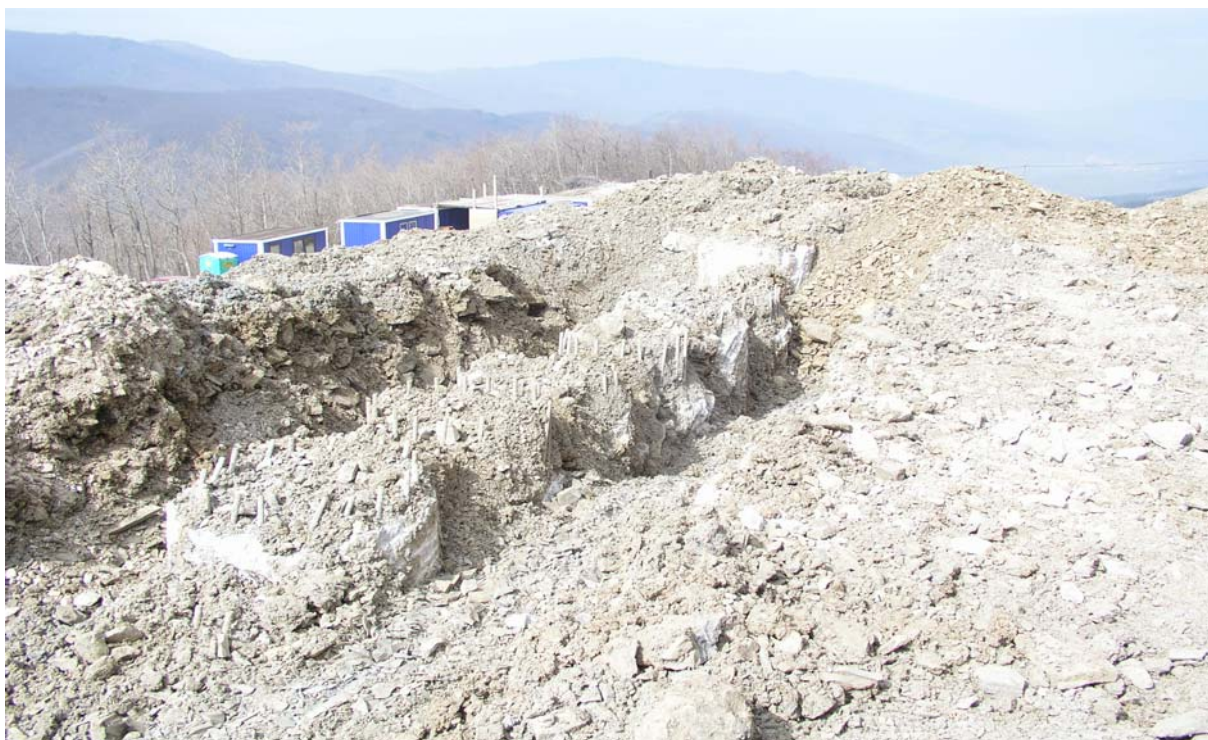
Slika 6: Zabetonirana glava pilota pred odbitjem nekvalitetnega betona
