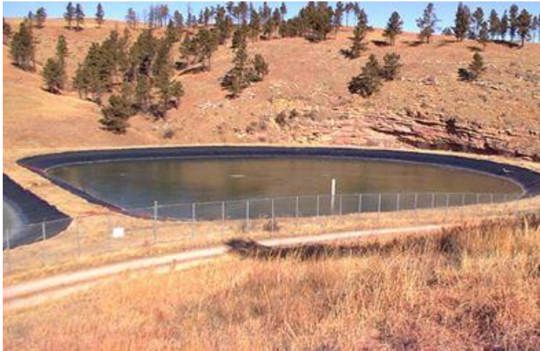
Slika 4: Laguna za čiščenje odpadne vode (egradiva)
