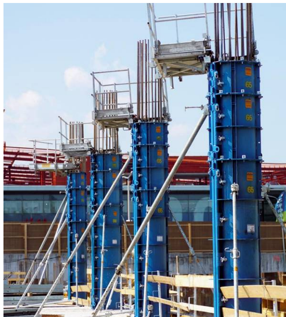
Slika 12: Konstrukcija RS opaža stebra ( http://www.doka.com )
