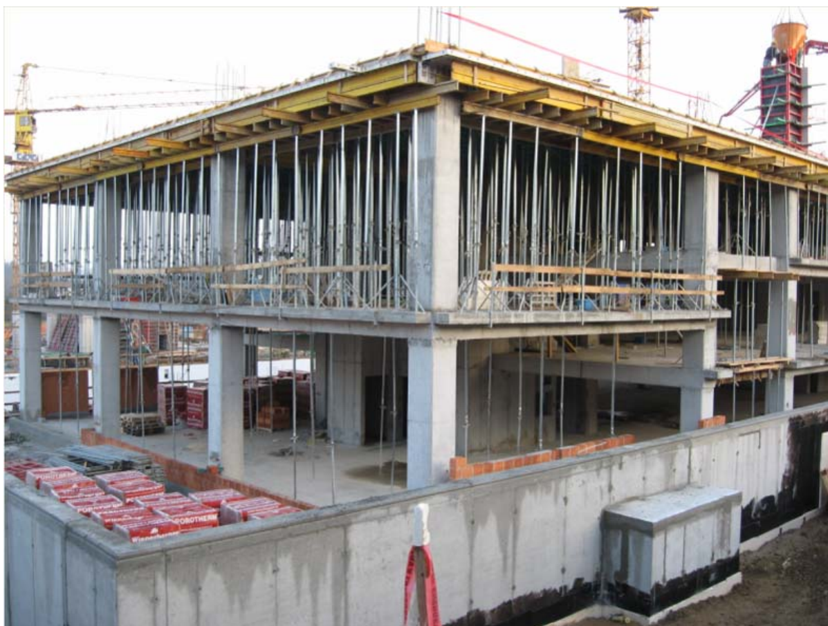
Slika 29: Objekt F1/2 med gradnjo (arhiv GPG d.d.)
