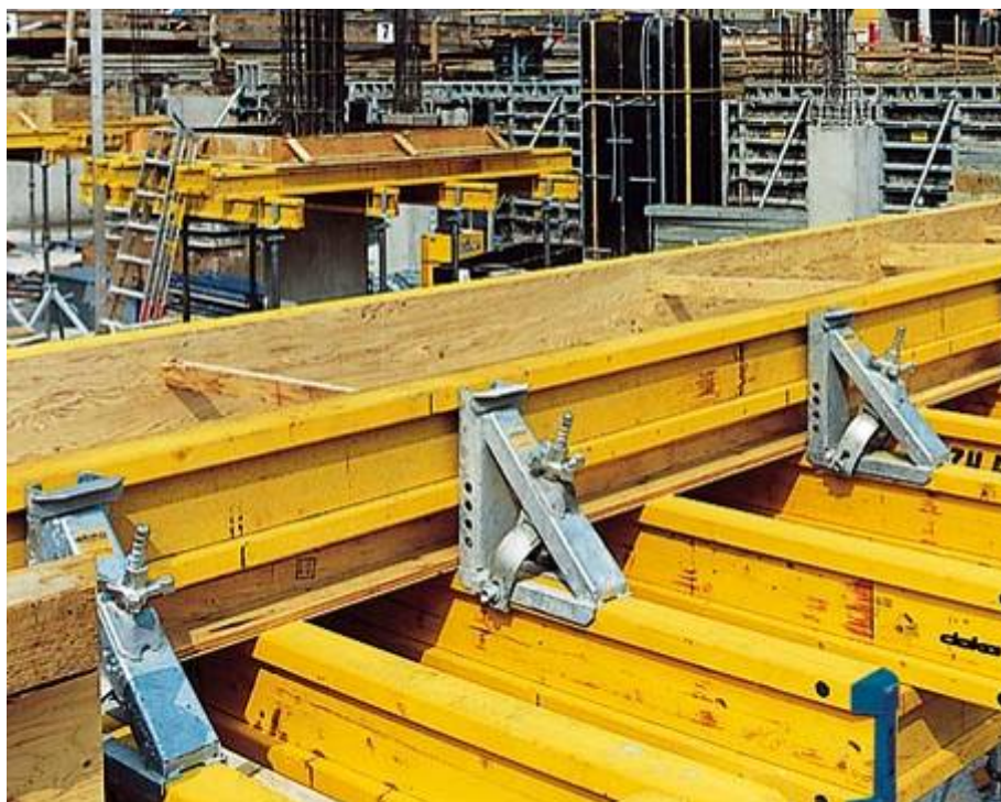
Slika 40: Tračna spona nosilca H 20 ( http://www.doka.com )
