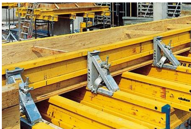
Slika 17: Opaženje s tračnimi sponami in izdelava varnostne ograje ( http://www.doka.com )
