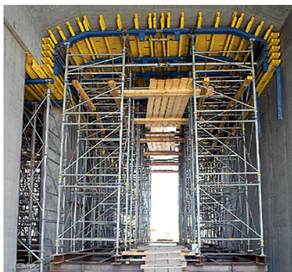
Slika 6: Nosilna konstrukcija iz podpornih stolpov ( http://www.doka.com )
