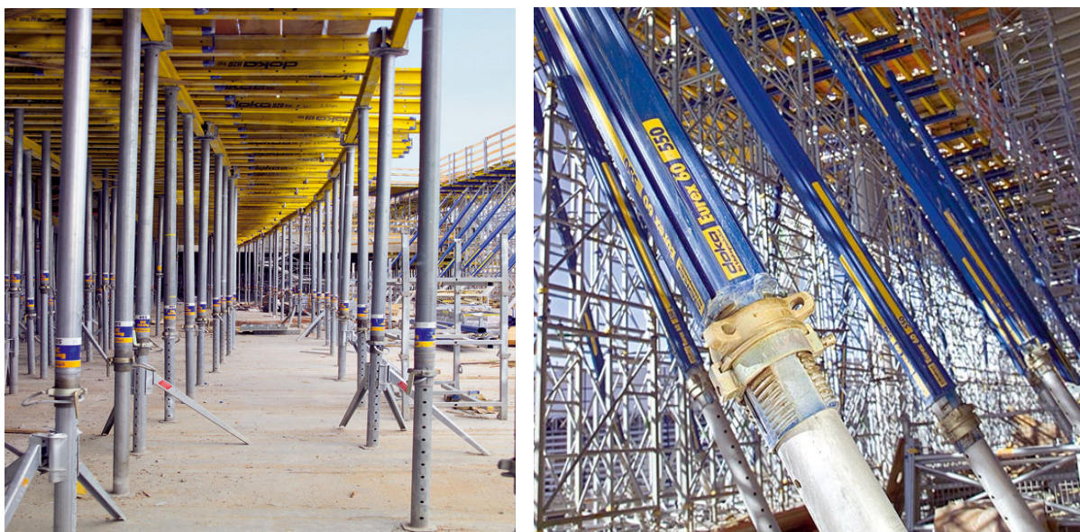
Slika 18: Podporniki Eurex 30 in Alu-Eurex 60 ( http://www.doka.com )
