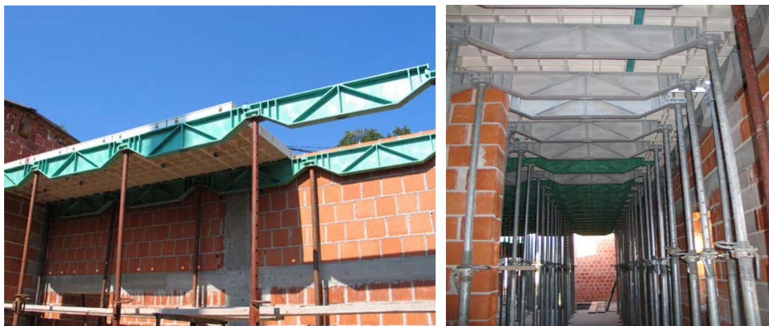
Slika 23: Elementi sistema EPIC ECO SKY SPEED ( http://www.epic.si )
