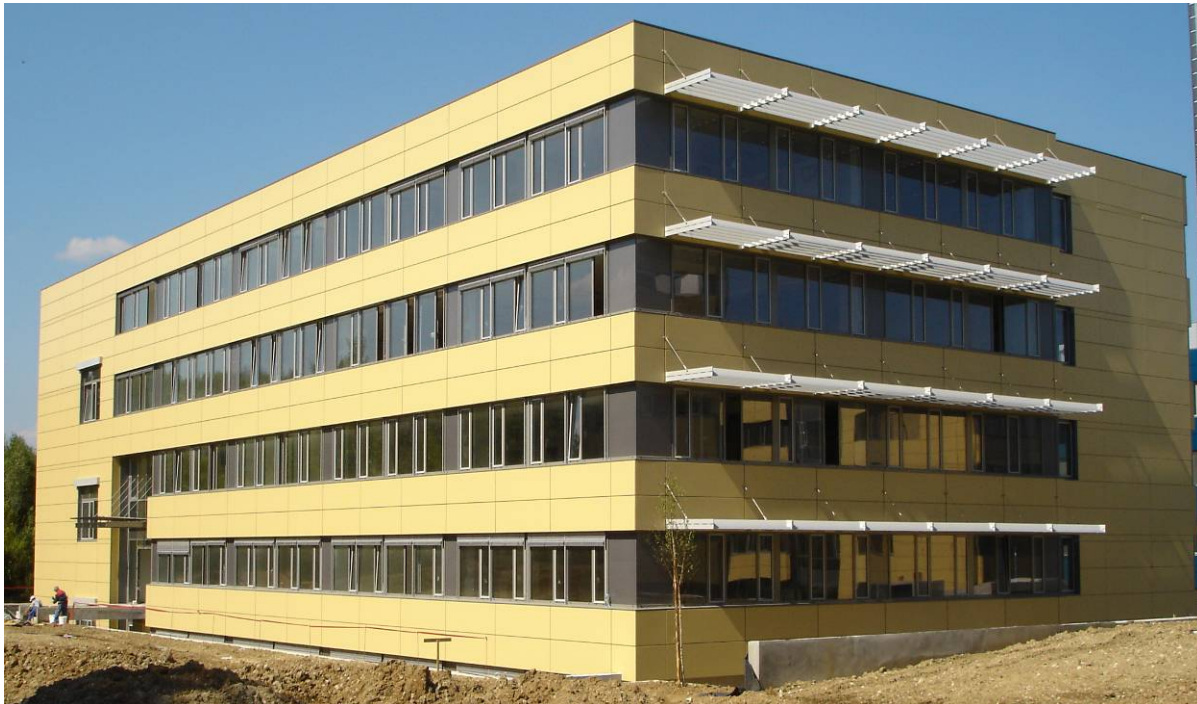
Slika 27: Objekt Tehnološki park Brdo
