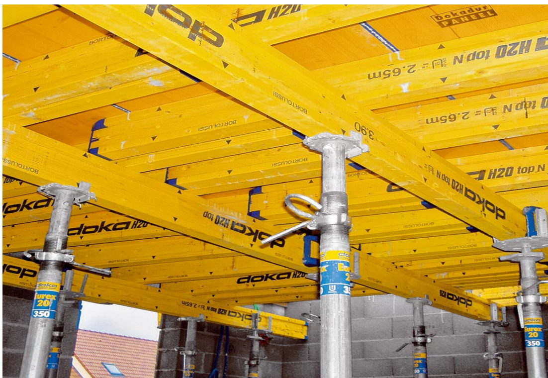
Slika 30: Primarni in sekundarni lepljeni nosilci ( http://www.doka.com )
