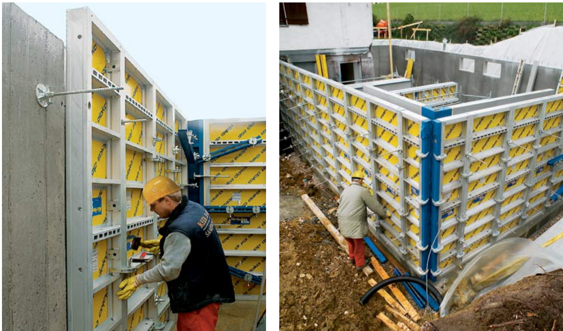
Slika 10: Okvirni opaž Alu-Framax Xlife s pripadajočim veznim materialom ( http://www.doka.com )
