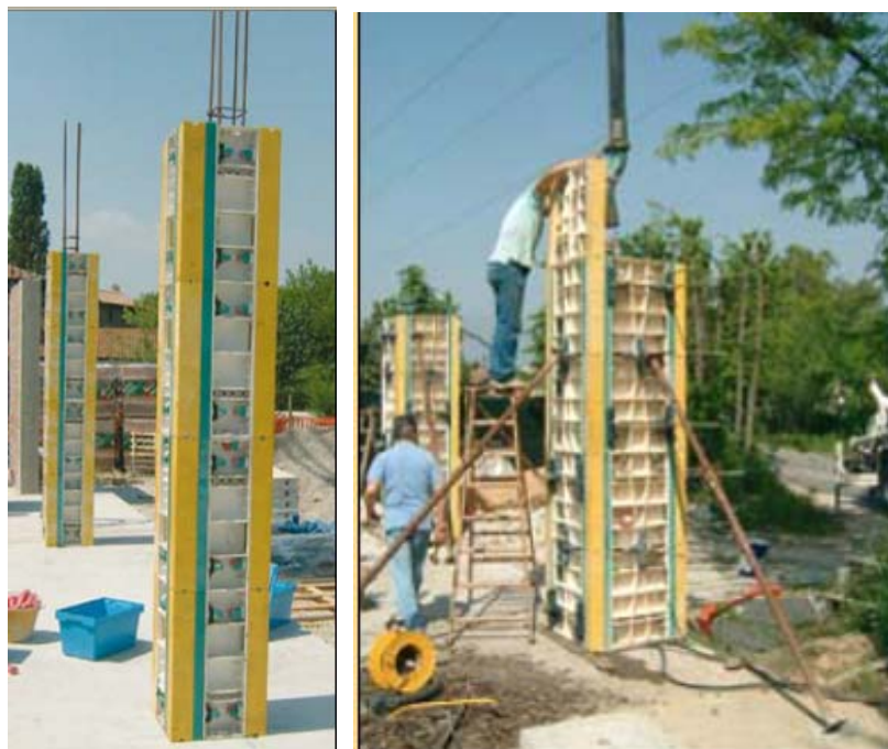
Slika 22: Opaž stebrov iz EPIC ECO elementov ( http://www.epic.si )
