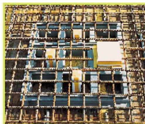
Slika 34: Jeklena strižna glava
