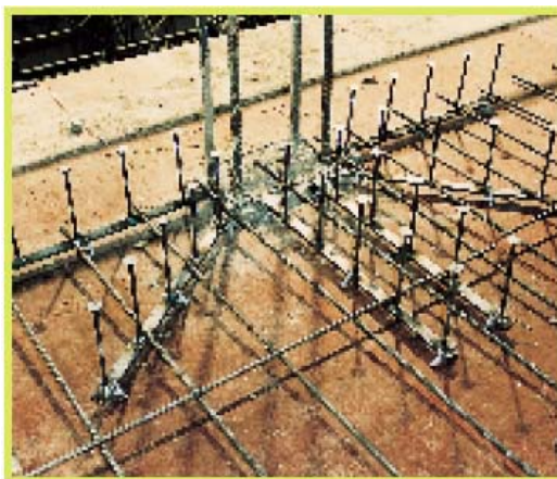
Slika 29: Mozniki za prevzem striga tip DEHA, ki se polagajo od spodaj
