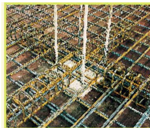
Slika 31: Notranji steber s križno formacijo ACI stremen
