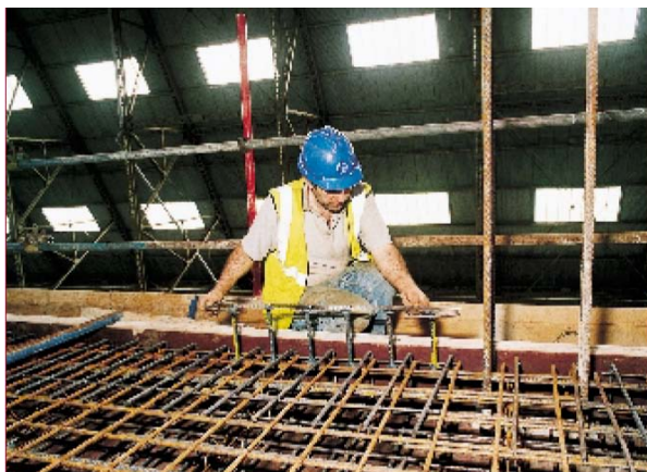
Slika 30: Montaža moznikov tipa AncoPLUS
