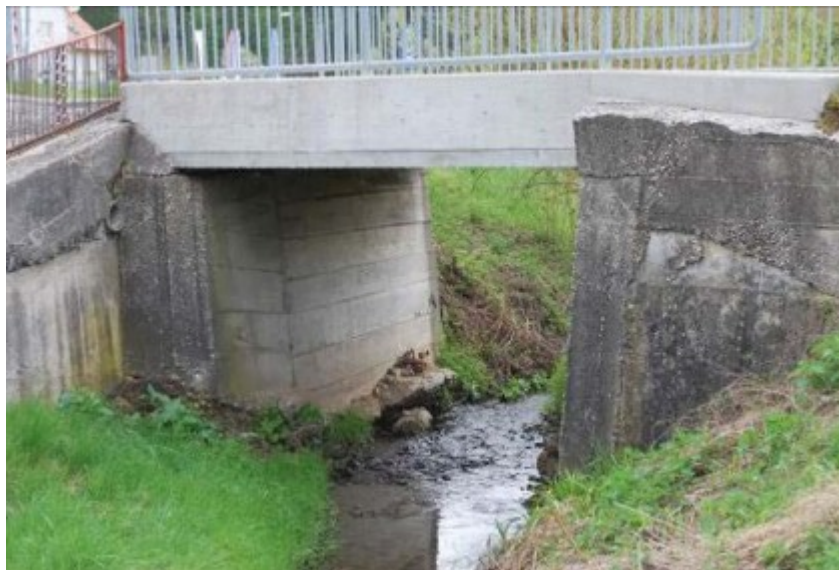
Slika 6: Dodatna zožitev rečne struge (Suhadolnik in Ivanuša, 2013, str. 65)
