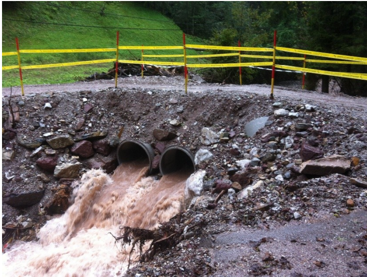
Slika 31: Začasni most namesto porušenega (foto: Nejc Žura)
