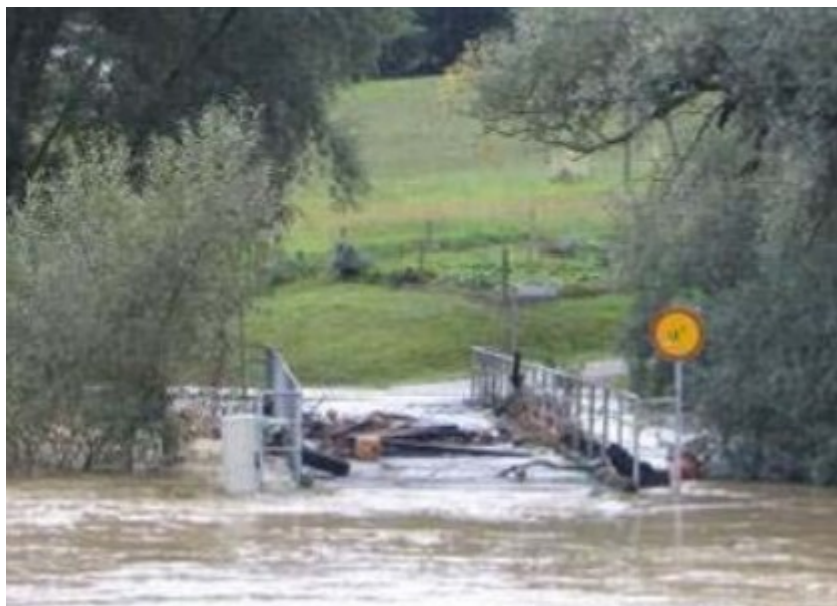
Slika 13: Odloženo plavje na mostu v Slapah (Suhadolnik in Ivanuša, 2013: 66)
