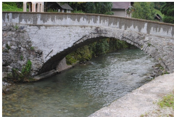
Slika 21: Delno obnovljen most proti Trnju (foto: Nejc Žura)
