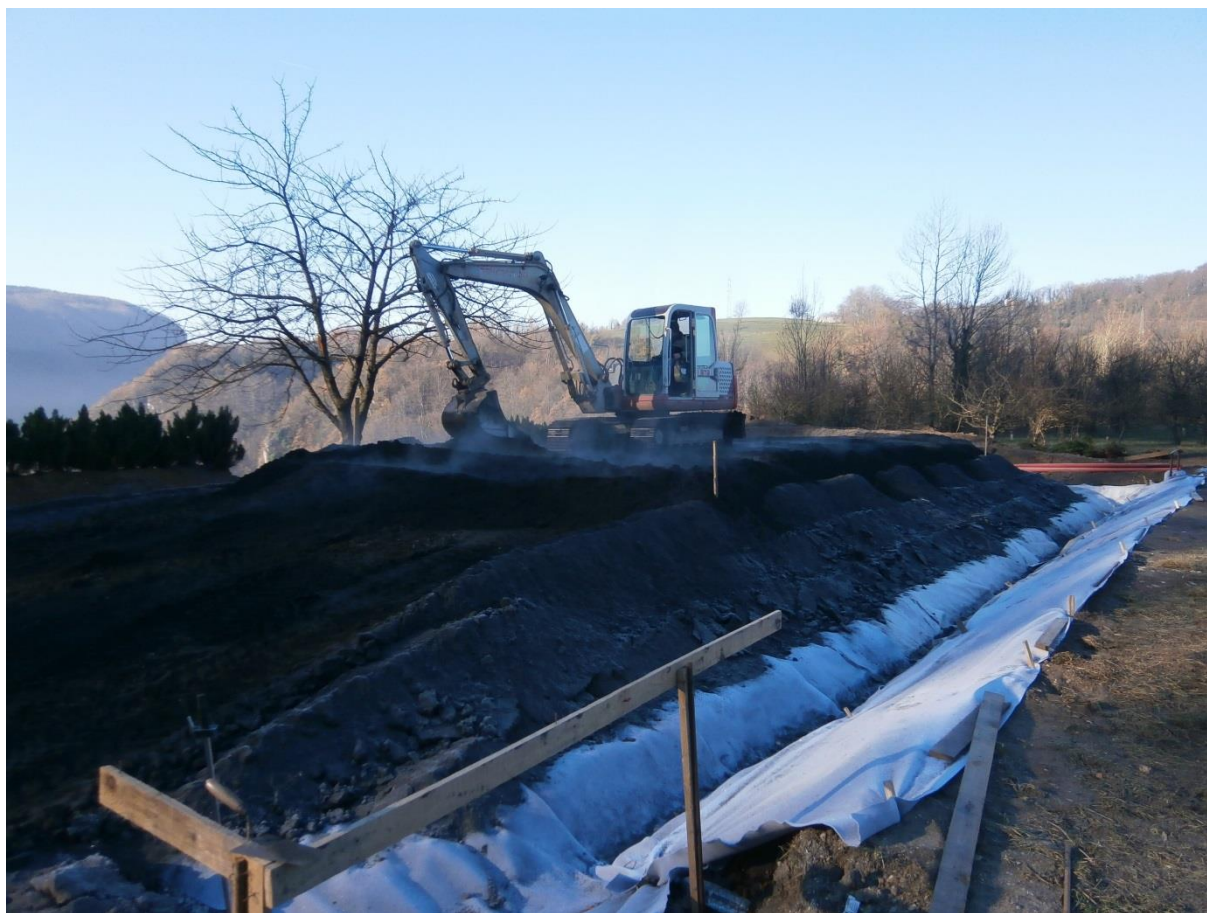
Slika 1b: Pogled na nasip iz žindre
