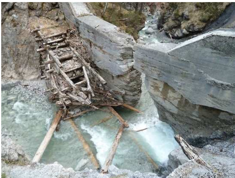
Slika 21: Hudourniška pregrada na Belci v km 2,48 leta 2012 (Foto: Martinčič, april 2012).
