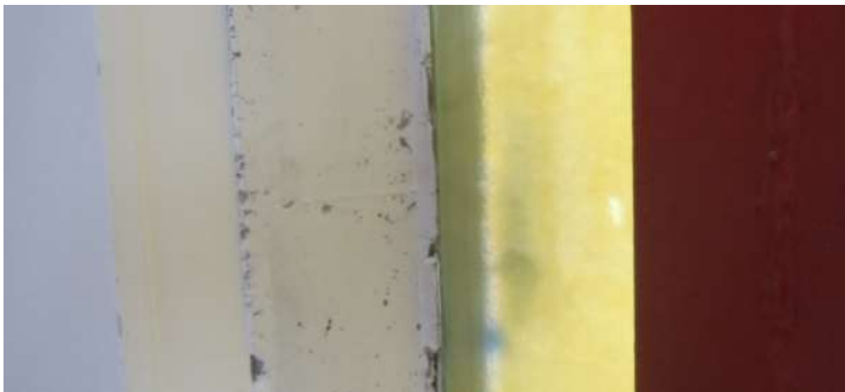
Slika 15: Zunanja stena Univerzitetne športne dvorane Rožna dolina z notranje strani (tapeta, iverna plošča, mineralna volna, viden beton) po prenovi, leto 2014 (lastni vir).
