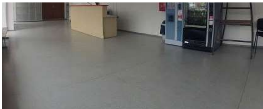
Slika 26: PVC prevleka položena čez talno keramiko v avli po prenovi, leto 2013 (lastni vir).
