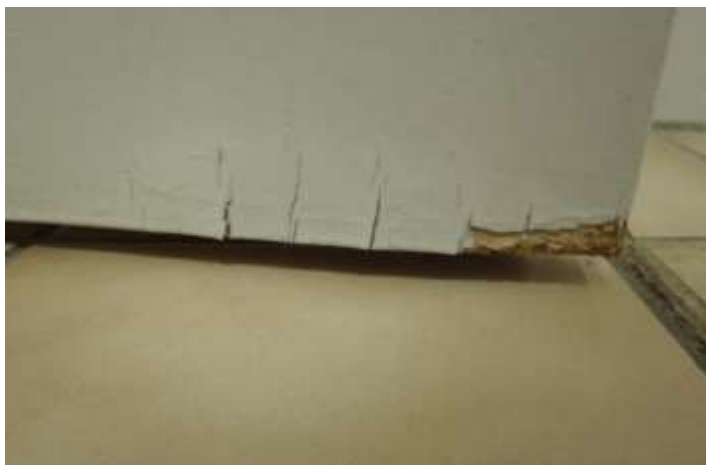
Slika 29: Vrata oblečena s PVC prevleko po prenovi, leto 2013, (lastni vir)
