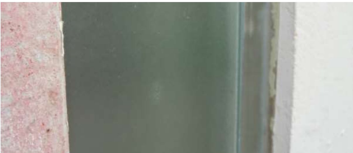
Slika 14: Fasada Univerzitetne športne dvorane Rožna dolina (viden beton, kopilit steklo) po prenovi, leto 2014 (lastni vir).
