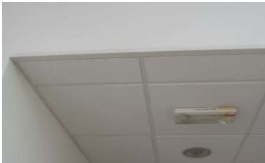
Slika 18: Strop iz mineralnih plošč v hodnikih in garderobnih prostorih po prenovi, leto 2013 (lastni vir).
