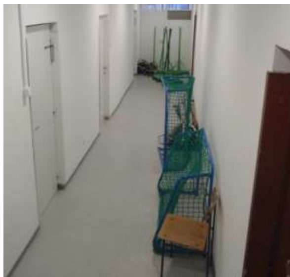
Slika 32: Neustrezno shranjevanje športne opreme na hodnikih in evakuacijskih poteh po prenovi, leto 2013, (lastni vir).
