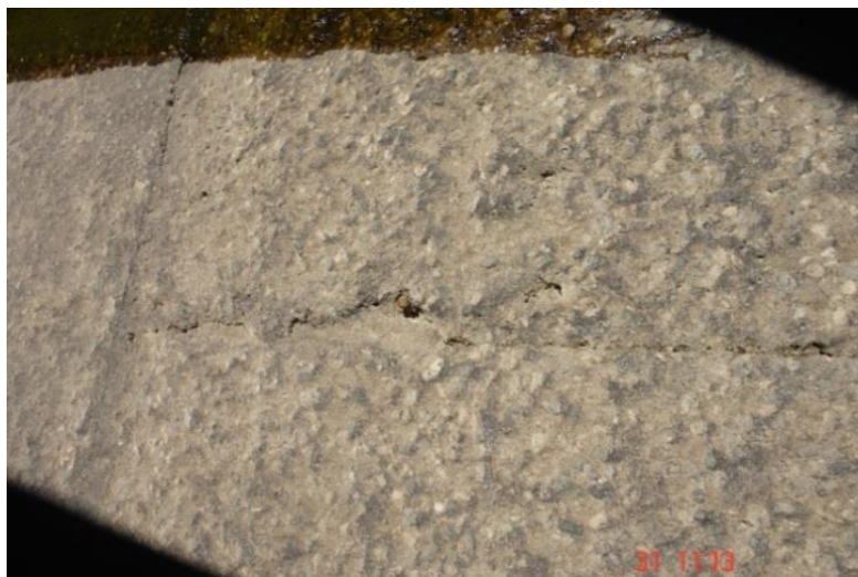
Slika 9: Pojav abrazijske erozije na prelivnem polju HE Krško (osebni arhiv)
