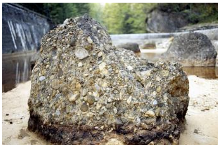
Slika 7: Zaradi delovanja abrazije močno poškodovan deflektor v podslapju (International Water Power & Dam Construction)
