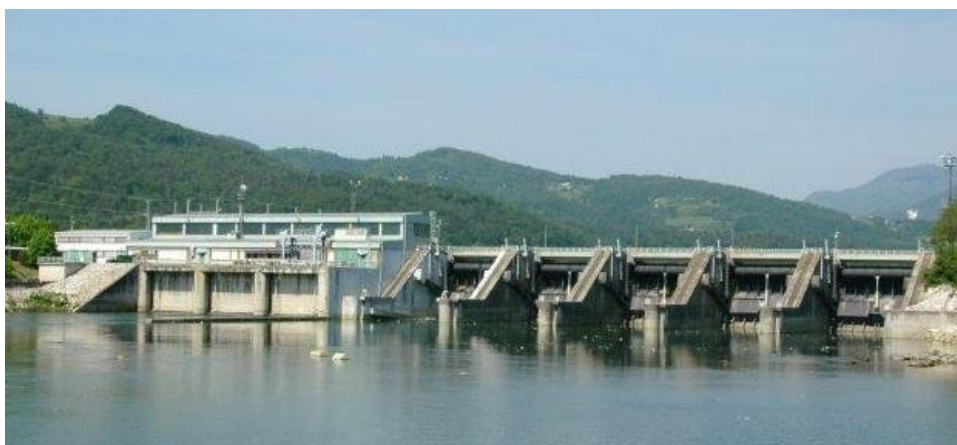
Slika 22: Hidroelektrarna Vrhovo (Savske elektrarne Ljubljana)
