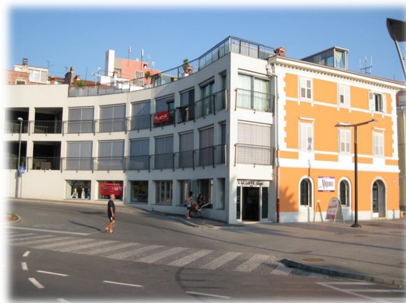
Slika 4: Pogled novega dela objekta B
