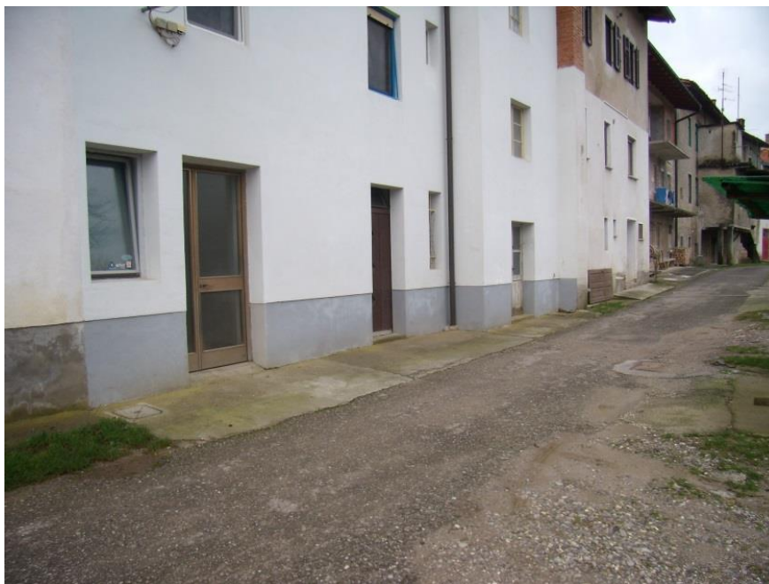
Slika 36: Stikajoči objekti pri zadnjem jezu v naselju Miren primerni za mokro ali suho tesnjenje
