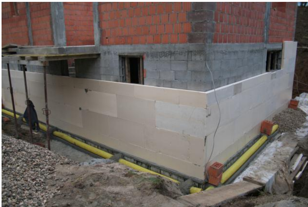
Slika 7: Postavljanje drenažnega sistema (Pod svojo streho, 2013)
