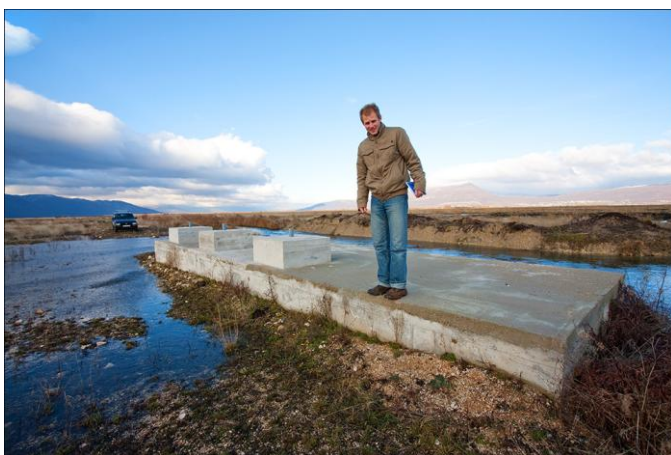
Slika 2: Obstoječi usedalnik, do katerega je speljana kanalizacija iz naselja Grborezi (Foto: Iztok Ameršek).
