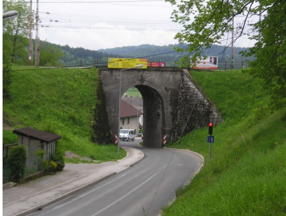
Slika 4: Obstoječe stanje – podvoz pod železnico v smeri Unca in A1 ( http://www.vlaki.info/ , 2013)
