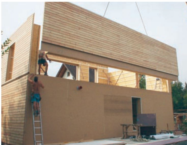
Slika 4.3: Sestavljanje objekta velikosti 150 m 2 , na gradbišču, Perchtoldsdorf, AU, 2001.
