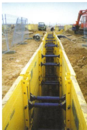
Slika 4: Izvedba kanalizacije z opaži (Vir podatkov: Katalog SBH Shoring systems)
