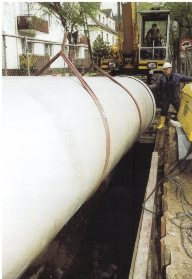
Slika 6: Način pritrditve cevi z uporabo dvižnih trakov (Vir podatkov: Katalog HOBAS Univerzalni cevovodi)
