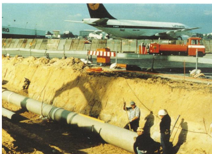
Slika 1: Izgradnja kanalizacije v širokem izkopu (Vir podatkov: Katalog HOBAS Univerzalni cevovodi)
