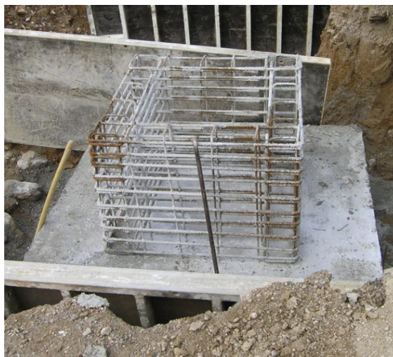
Slika 3: Armatura čaše temelja
