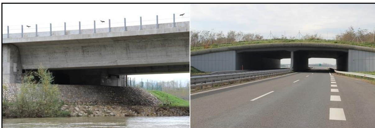
Slika 44: Prehod za prostoživeče živali (levo: podhod na avtocestnem odseku Krška vas–Obrežje; desno: nadhod (ekodukt) na avtocestnem odseku Vučja vas–Lendava) (Barkovič, 2012)
