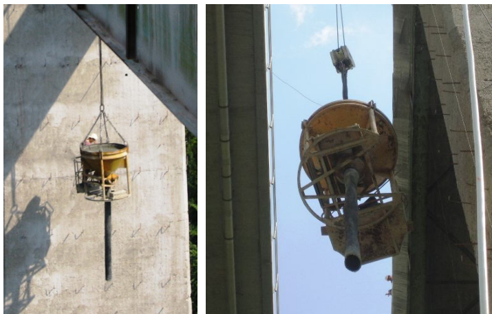
Slika 50: Uporaba »kible« predvsem na težko dostopnih mestih, kjer ni možen dostop z avtomešalcem in avtočrpalko.
