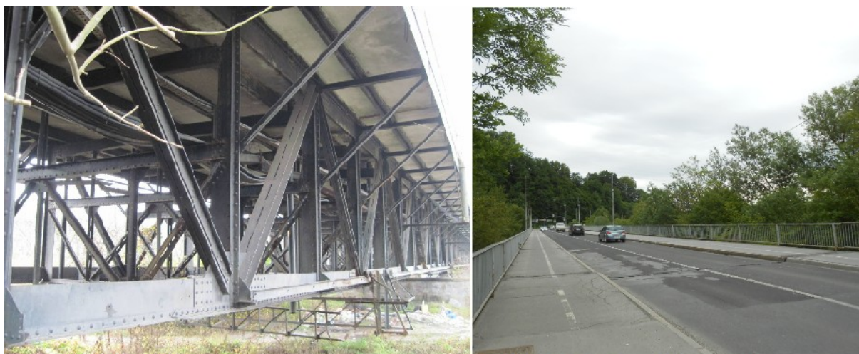
a.) Pogled na jekleno nosilno konstrukcijo mostu
