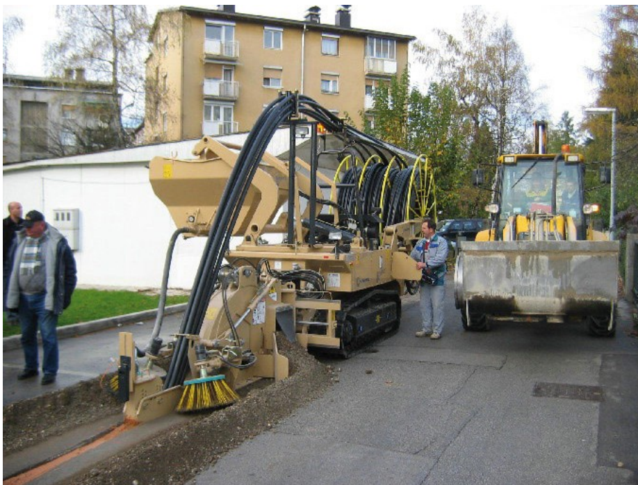
Slika 3: Prikaz najnovejše tehnologije izkopa in polaganja cevi (Gratel 2007)
