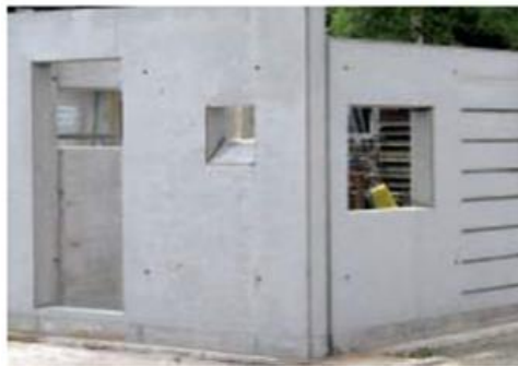
Slika 1: Uporaba samozgoščevalnega lahko agregatnega betona v montažni industriji. [10]
