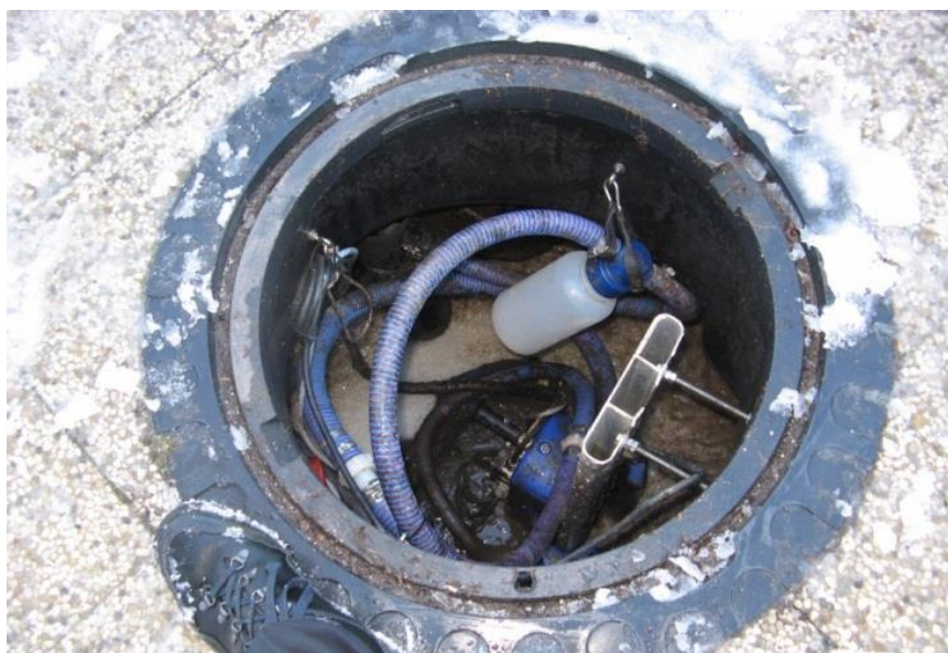
Slika 19: Iztok na ČN na Lubniku. Na sliki vidna posoda (1,5l) - vzorec očiščene odpadne vode
