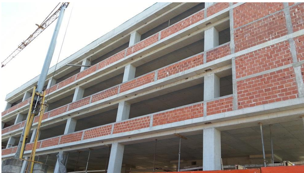
Slika 62: Ločitev ravnine stebra in ravnine polnila
