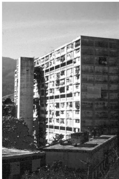
Slika 51: Na sliki lahko opazimo nepoškodovano konstrukcijo z delnimi parapeti [30]
