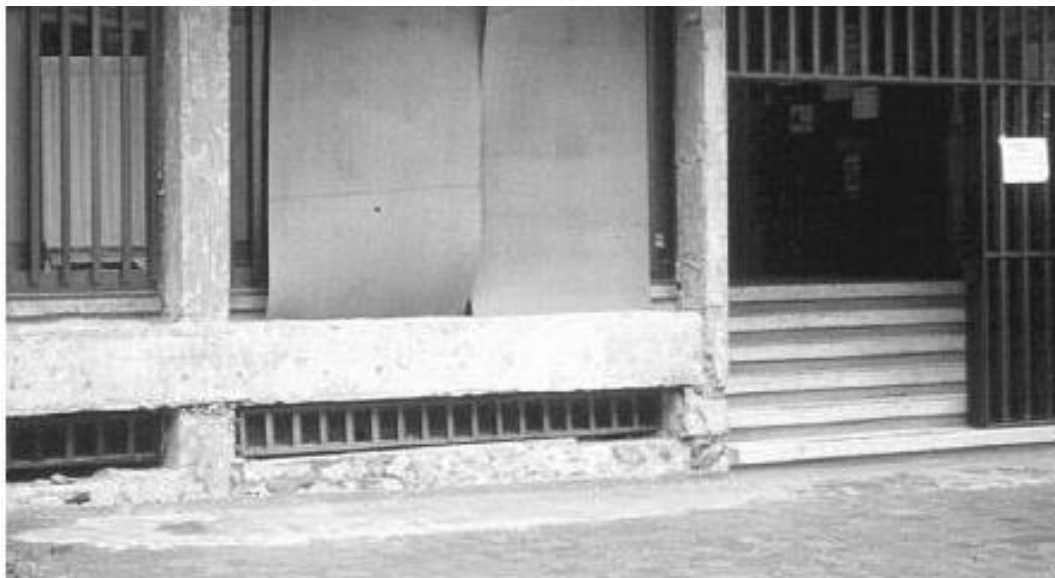
Slika 55: Efekt ujetega stebra v kleti [30]
