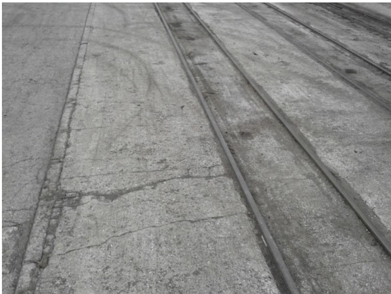
Slika 7: Obraba betonskega vozišča
