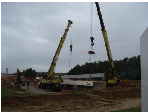
Slika 4. Početak montaže konstrukcije
