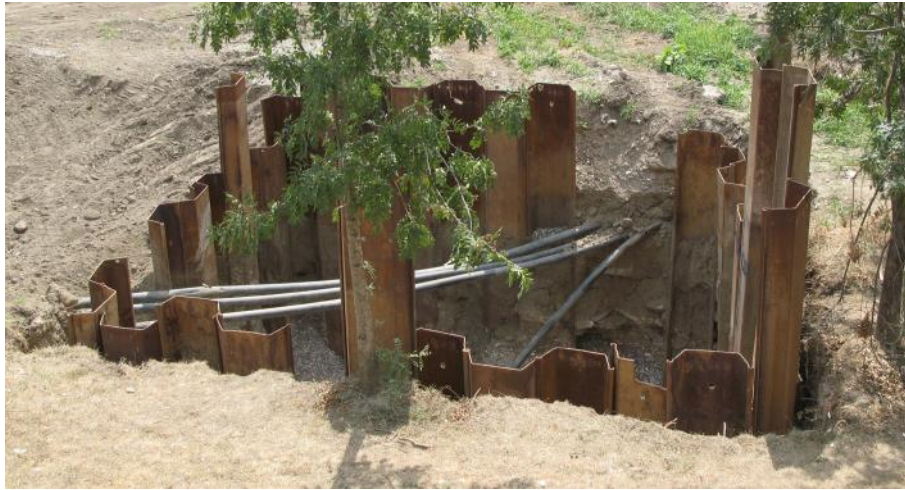
Slika 5. Telekomunikacijske instalacije na mjestu ulazne/izlazne jame s istočne strane
