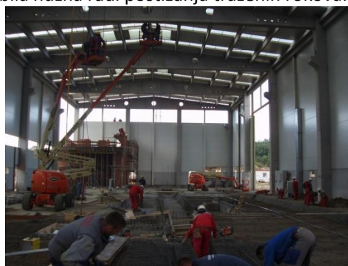
Slika 6. Unutarnji građevinski i instalaterski radovi
