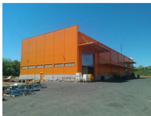
Slika 6. Završena građevina lakirnice
