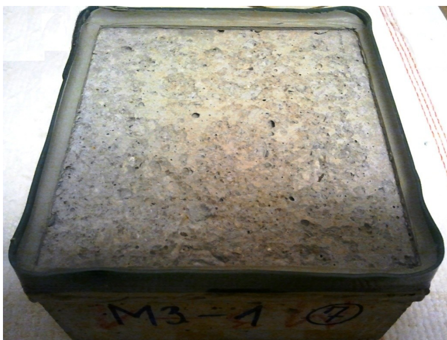
Slika 23: Močno poškodovana površina betona mešanice M3
