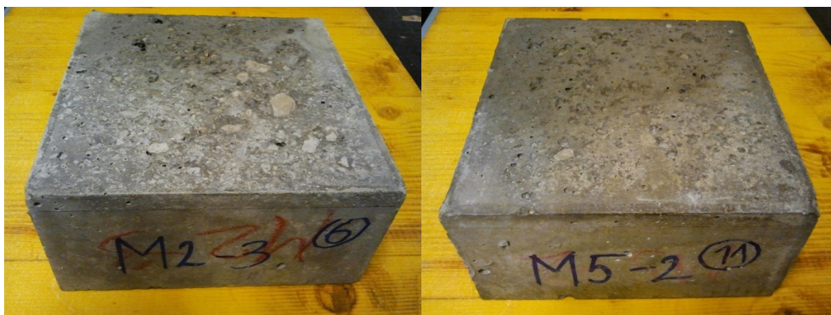
Slika 26: Primerjava poškodb površine mešanic M2 ter M5
