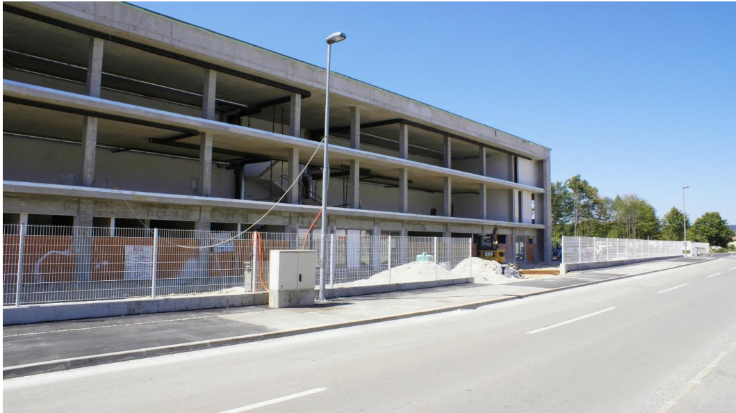
Slika 2: Nosilna konstrukcija poslovnega dela v času gradnje
