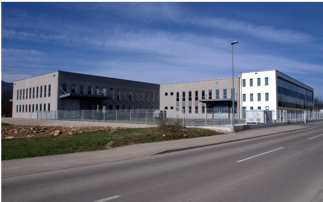
Slika 1: Celoten proizvodno - poslovni objekt
