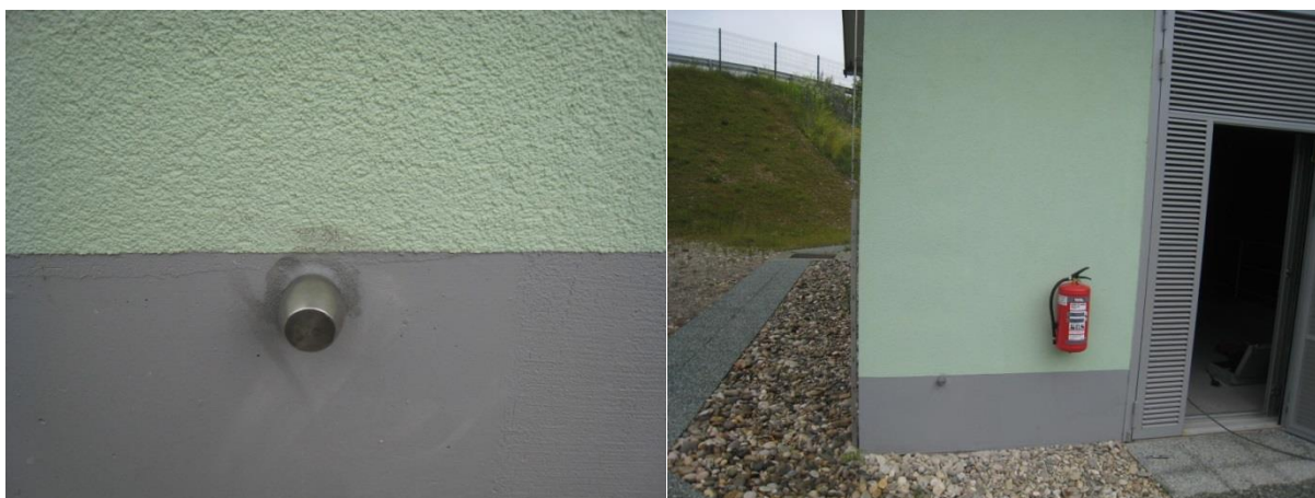
Slika 10: Stabiliziran reper E2 in njegov položaj na objektu MHE (Vir: Dobriča)
