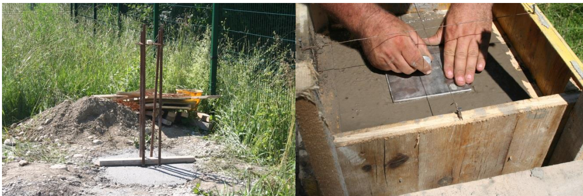
Slika 6: Vzpostavljanje novega referenčnega stebra O8 (Vir: Horvat)
