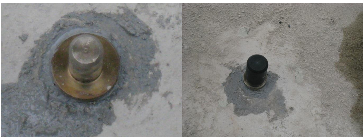
Slika 9: Stabilizirana kontrolna točka brez in s pokrovčkom (Vir: Dobriča)
