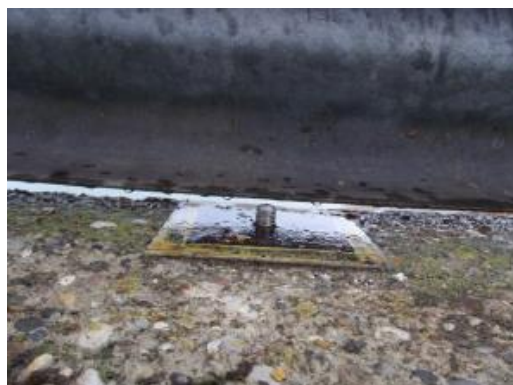
Slika 12: Primer stabilizacije kontrolnih točk na jezovni zgradbi (Vir: Projektna naloga)
