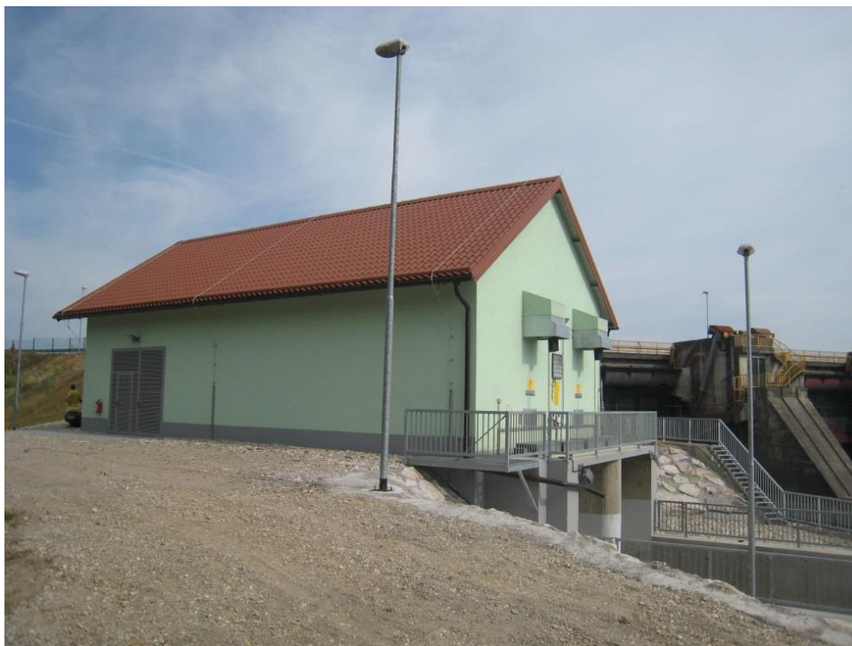
Slika 2: Mala hidroelektrarna Markovci (Vir: Dobriča)
