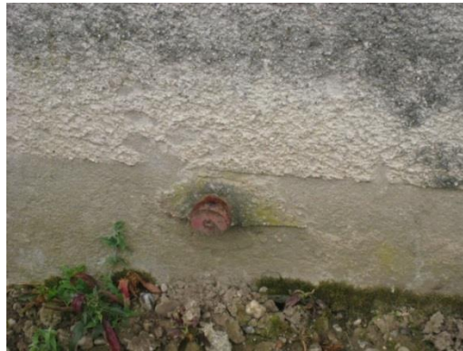
Slika 11: Stabiliziran izhodiščni reper R37 (Vir: Dobriša)
