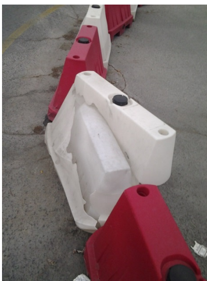
Slika 35: Poškodovana ločilna ograja
