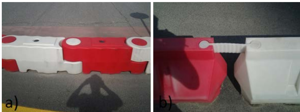
Slika 41: Izvedba povezljivosti ločilne ograje; a) členkasta izvedba, b) dodatek za povezljivost
