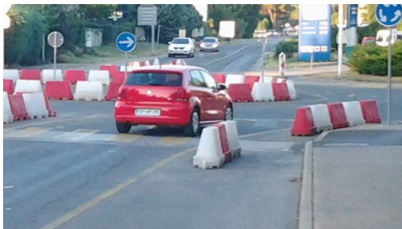
Slika 13: Zožitev pasu na kraku A, krožišče Jadranka
