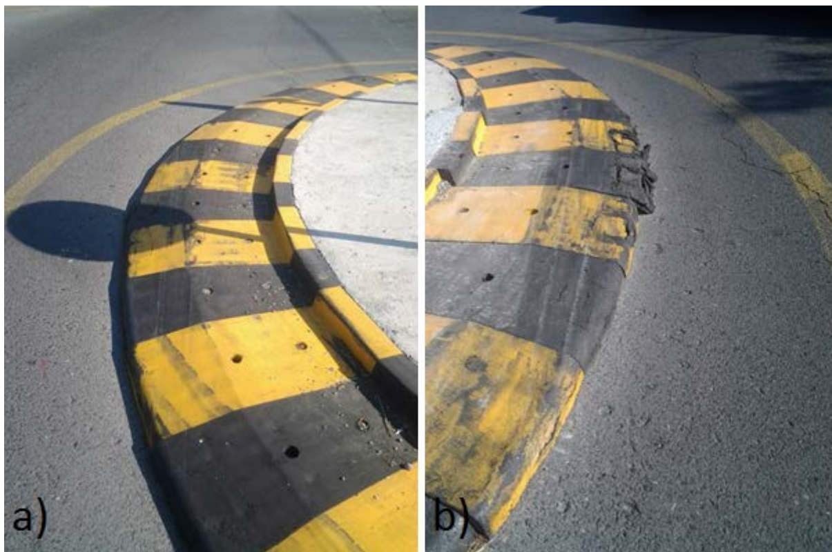
Slika 22: Obrabljenost robnika sredinskega otoka, krožišče Jagodje; a) smer A–C, b) smer C–A
