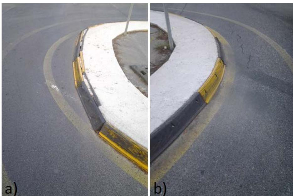
Slika 33: Nepravilnost sredinskega otoka krožišča Strunjan; a) smer C–A, b) smer A–C
