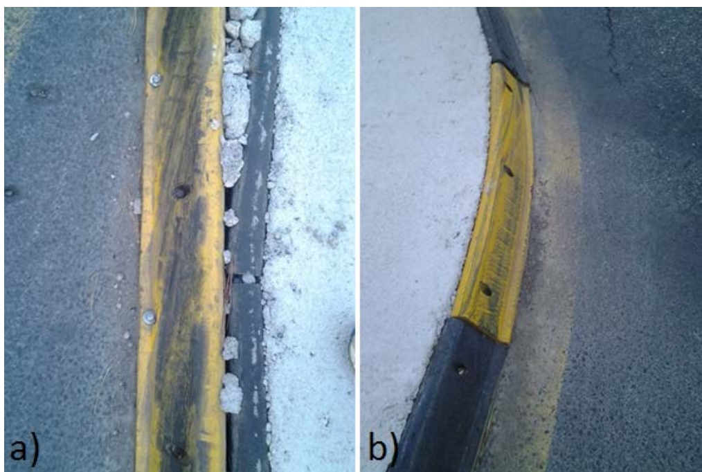
Slika 30: Obrabljenost robnika sredinskega otoka, krožišče Strunjan; a) smer C–A, b) smer A–C
