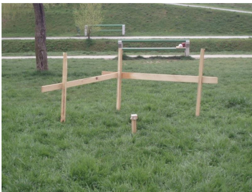
Slika 9: Zavarovanje točke z gradbenimi profili
