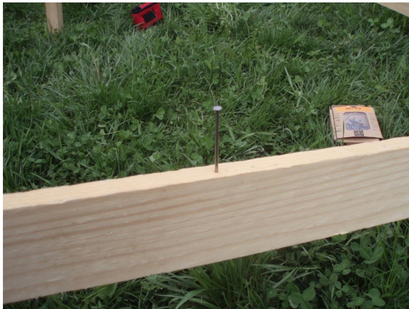
Slika 11: Oznaka zakoličenih točk na gradbenih profilih
