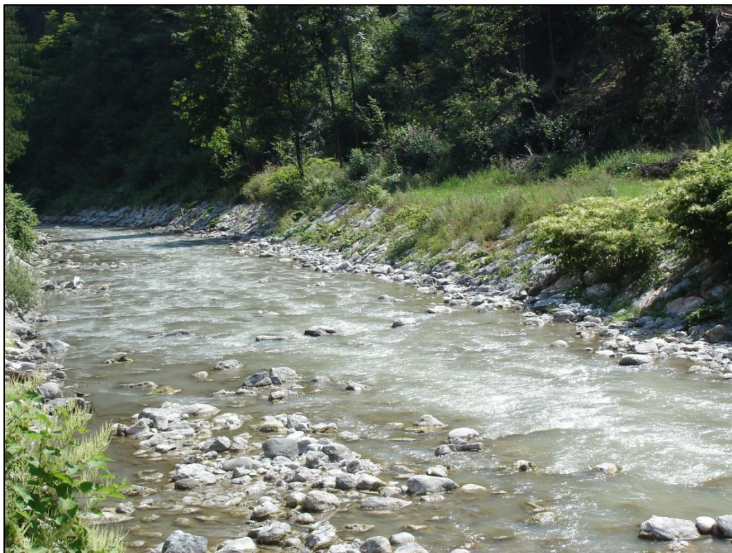
Slika 3: Desnoobrežno zavarovanje, pogled dolvodno.
