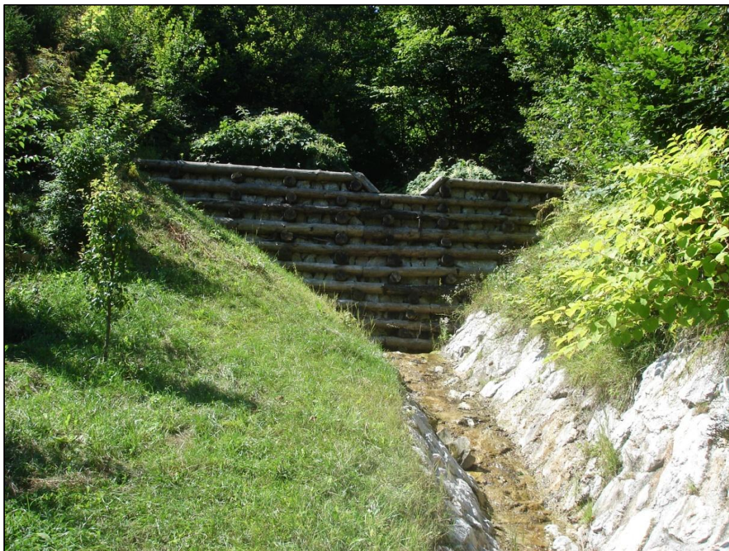
Slika 1: Gorvodni pogled na zaplavno kaštno pregrado.
