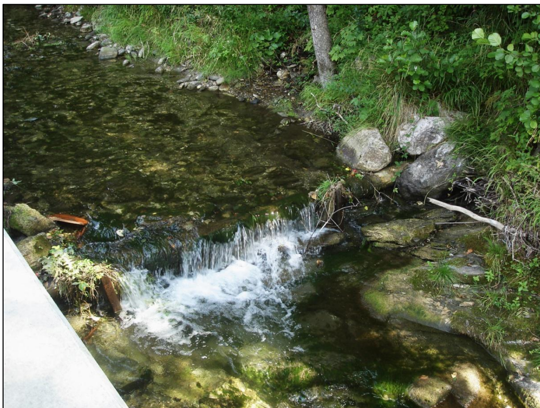
Slika 2: Leseni prag, pogled gorvodno.
