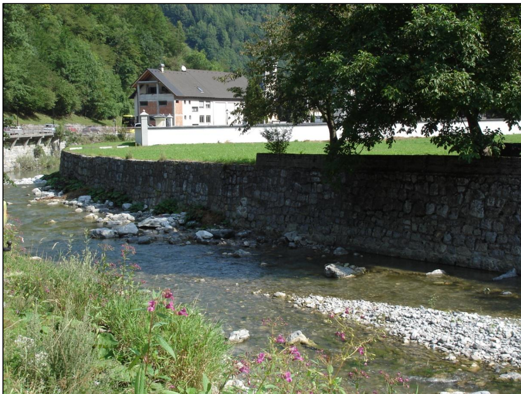
Slika 5: Desnoobrežni kamnito-betonski zid v zgornjem delu, pogled dolvodno.
