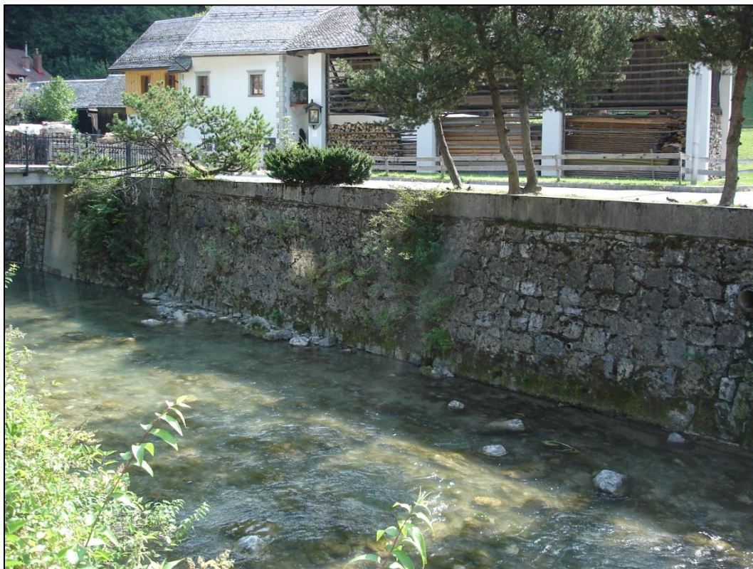
Slika 1: Desnoobrežni kamnito-betonski zid v spodnjem delu, pogled dolvodno.
