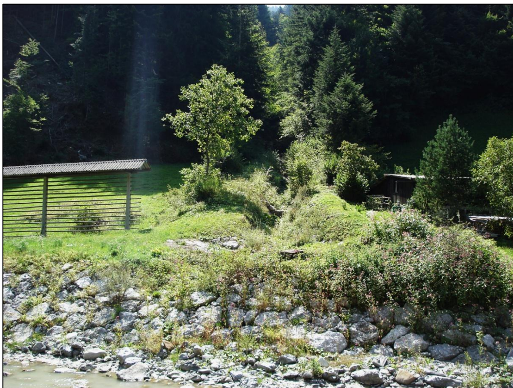
Slika 4: Zložba iz kamna v suho v zgornjem delu, pogled dolvodno.
