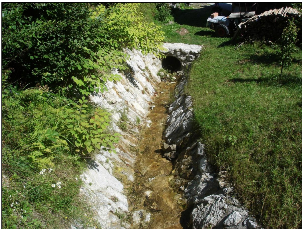
Slika 2: Vtok kanalete iz kamna v betonu v cevni prepust.
