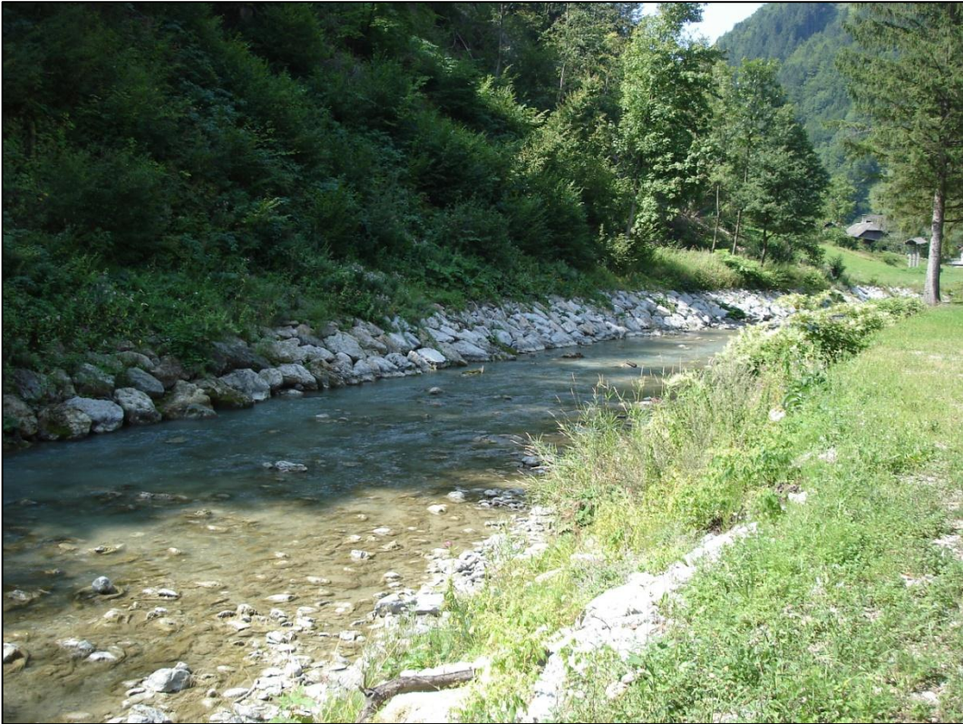
Slika 1: Desnoobrežna zložba, pogled gorvodno.
