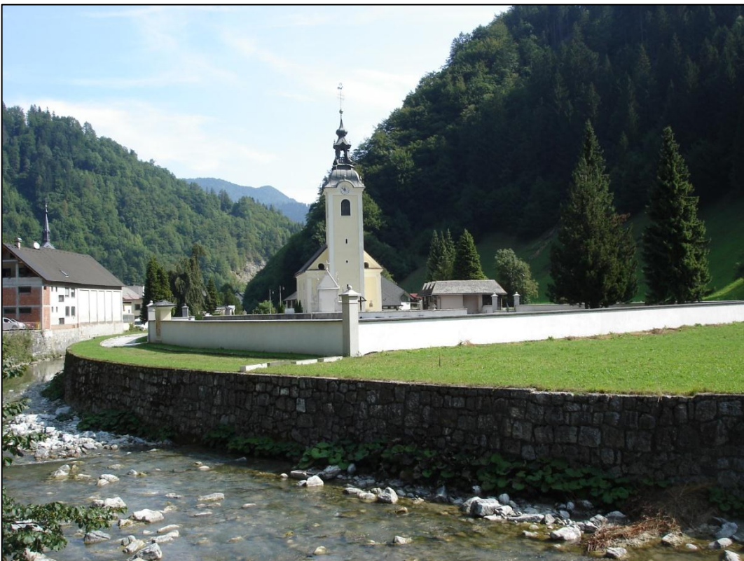
Slika 4: Desnoobrežni kamnito-betonski zid v srednjem delu, pogled dolvodno.
