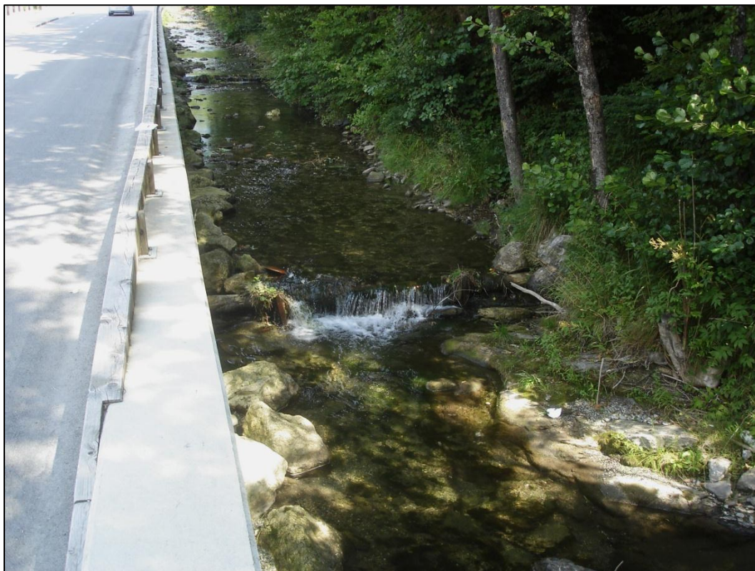
Slika 1: Leseni prag, pogled gorvodno.
