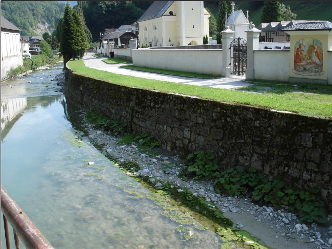
Slika 3: Desnoobrežni kamnito-betonski zid v srednjem delu, pogled dolvodno.
