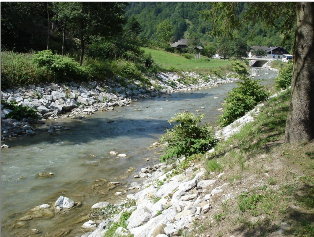
Slika 2: Zložba iz kamna v suho, pogled gorvodno.
