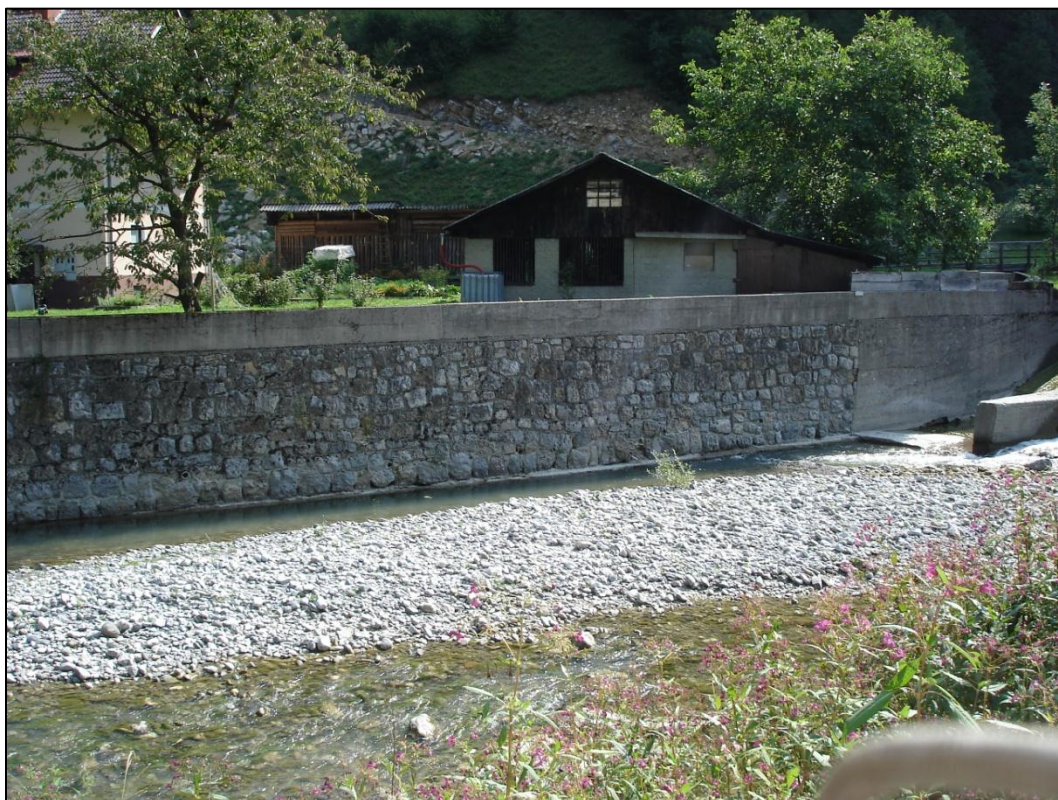
Slika 6: Desnoobrežni kamnito-betonski zid pri Dermotovem jezu, pogled gorvodno.
