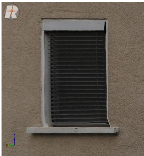
Slika 73: Detajl na fasadi.
