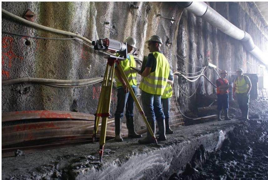
Slika 1: Izvajanje meritev s terestričnim laserskim skenerjem VZ-400 v tunelu (Riegl, 2013).
