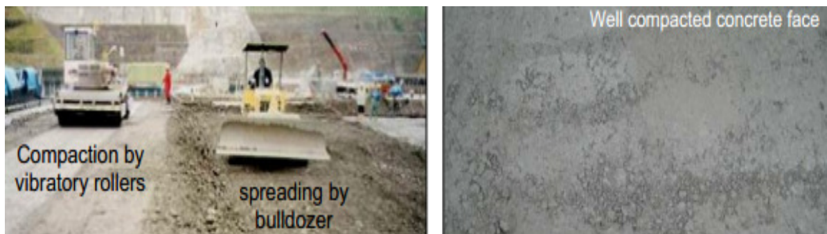
Slika 19: Planiranje in kompaktiranje RCD betona (Nagataki et al., 2008)
