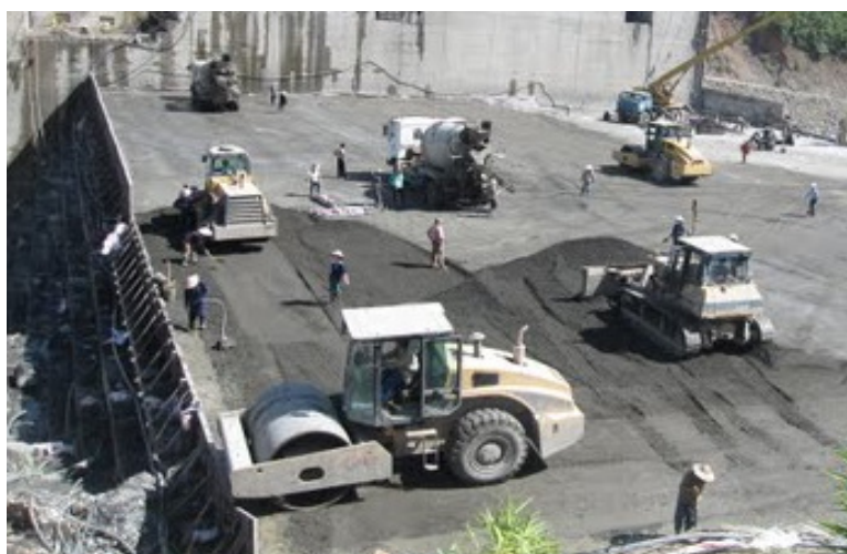
Slika 42: Vgradnja RCC valjanega betona
