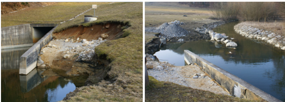
Slika 10: Erozijska zajeda
