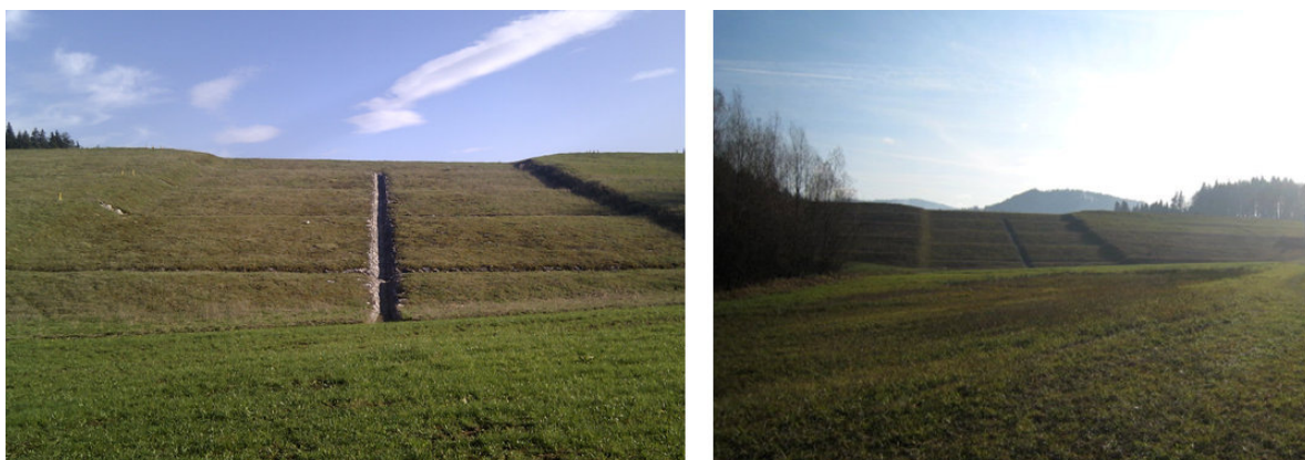
Slika 5: Preliv za visoke vode pregrade Drtijaščica
