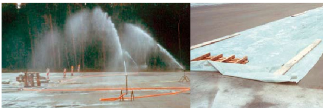
Slika 45: Nega betona po vgradnji
