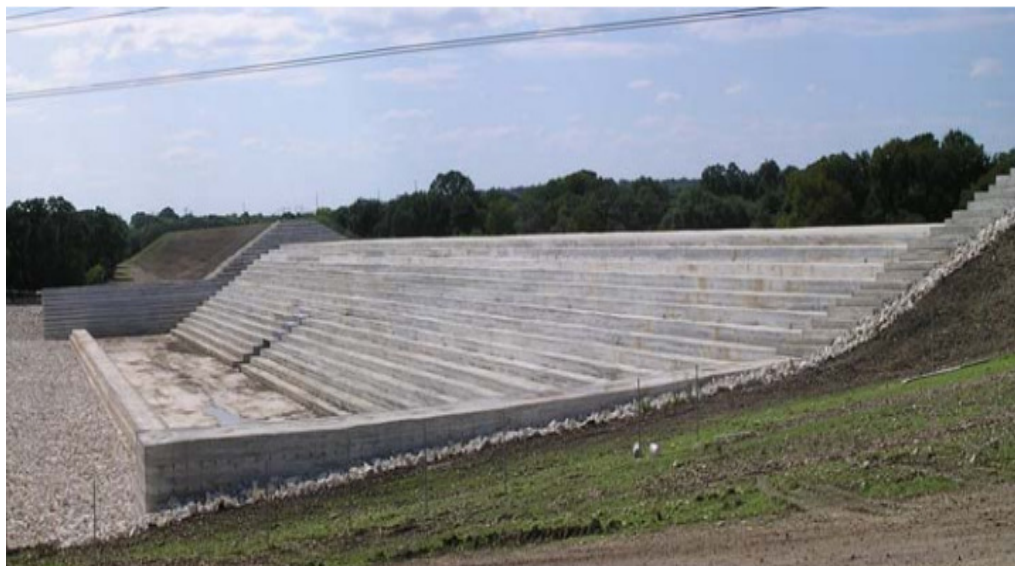
Slika 28: Primer RCC prelivnega polja zemeljske pregrade Salado Creek (Chanson, 2009)
