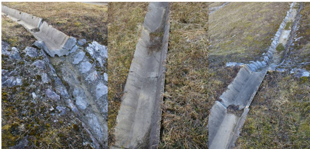
Slika 8: Obstojče stanje kanalet za odvodnjavanje padavinskih voda
