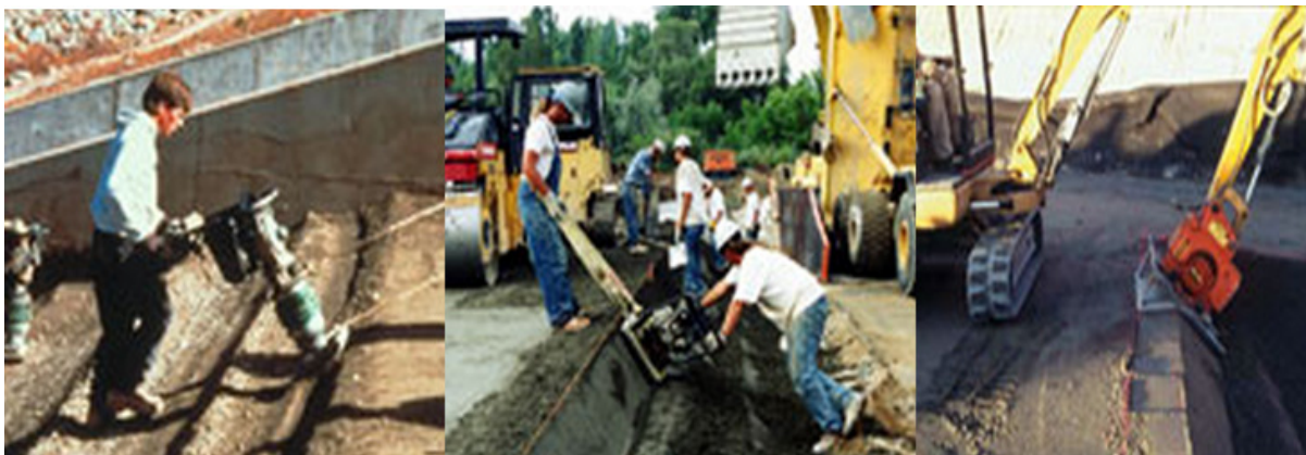
Slika 15: Načini formiranja čelnih delov stopenj RCC preliva ( http://www.cement.org )
