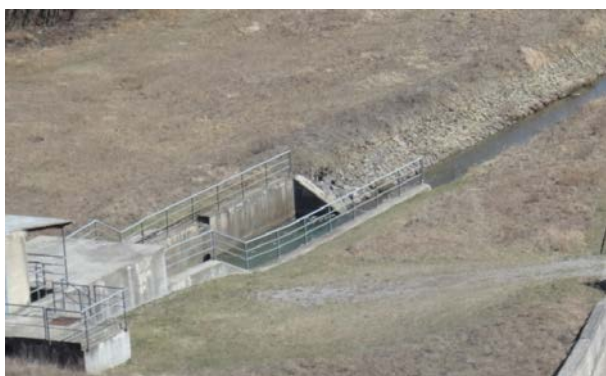
a) Podslapje in kanal obložen s kamnometom
