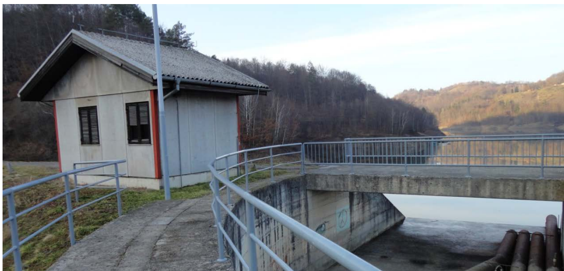
Slika 11: Objekt za upravljanje in most za prehod prelivnega objekta (vir: osebni arhiv)
