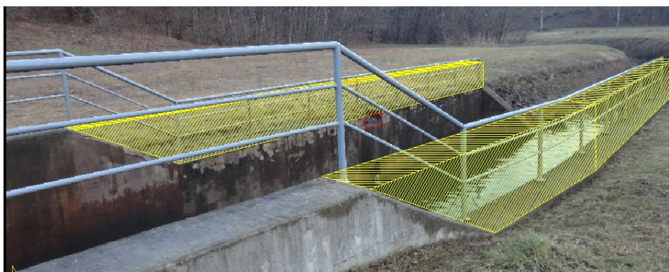
Slika 36: Nadvišana bočna zidova podslapja talnega izpusta
