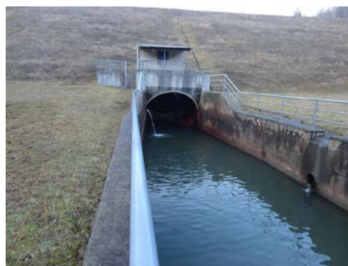
b) Podslapje in zapornični objekt
