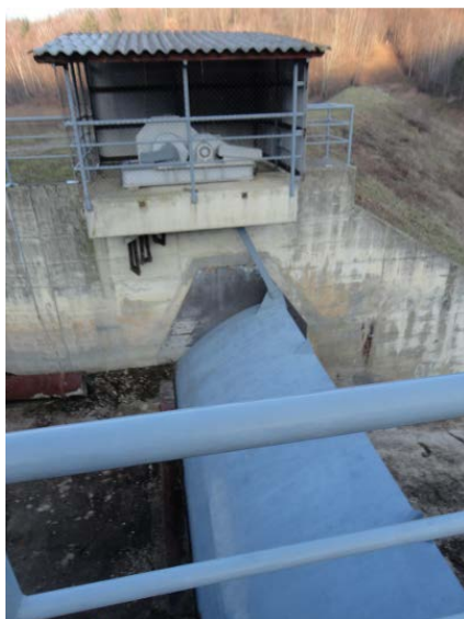
a) Zaklopka in objekt za krmiljenje zaklopke
