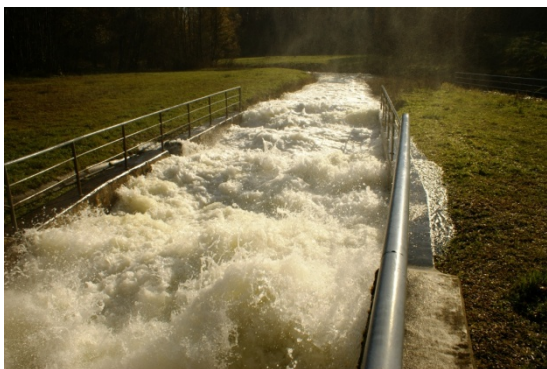
a) Prelivanje vodnega skoka iz podslapja talnega izpusta
