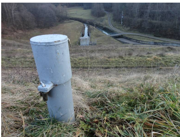
Slika 12: Piezometer tik pod krono pregrade (vir: osebni arhiv)
