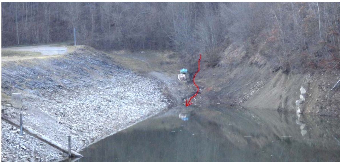
Slika 43: Iztok zaledne vode v akumulacijo, tik ob pregradi; prostor, ki bi ga bilo potrebno zasuti z materialom (vir: osebni arhiv)
