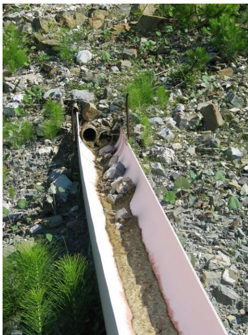
Slika 16: Zajem izvira na plazu Slano blato (Vir: Mikec, 2012)
