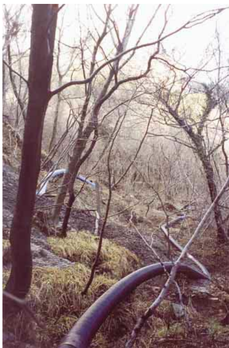
Slika 10: Odvod vode iz območja plazu po plastičnih ceveh (Vir: Kovač, 2000/2001: str. 127)
