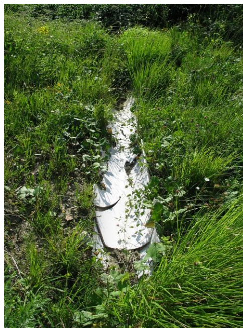
Sliki 60 in 61: Prestavljene in poškodovane polovične cevi kanala 3
