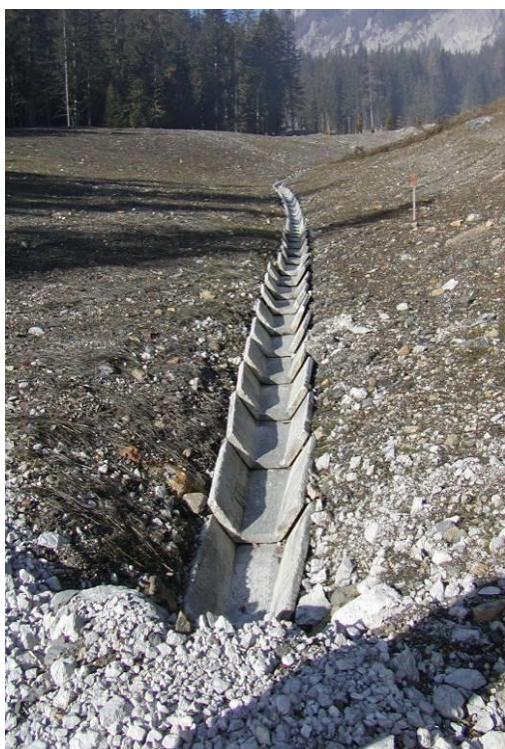
Slika 14 : Betonska koritnica za površinsko odvodnjo (Vir: Fazarinc, 2004)
