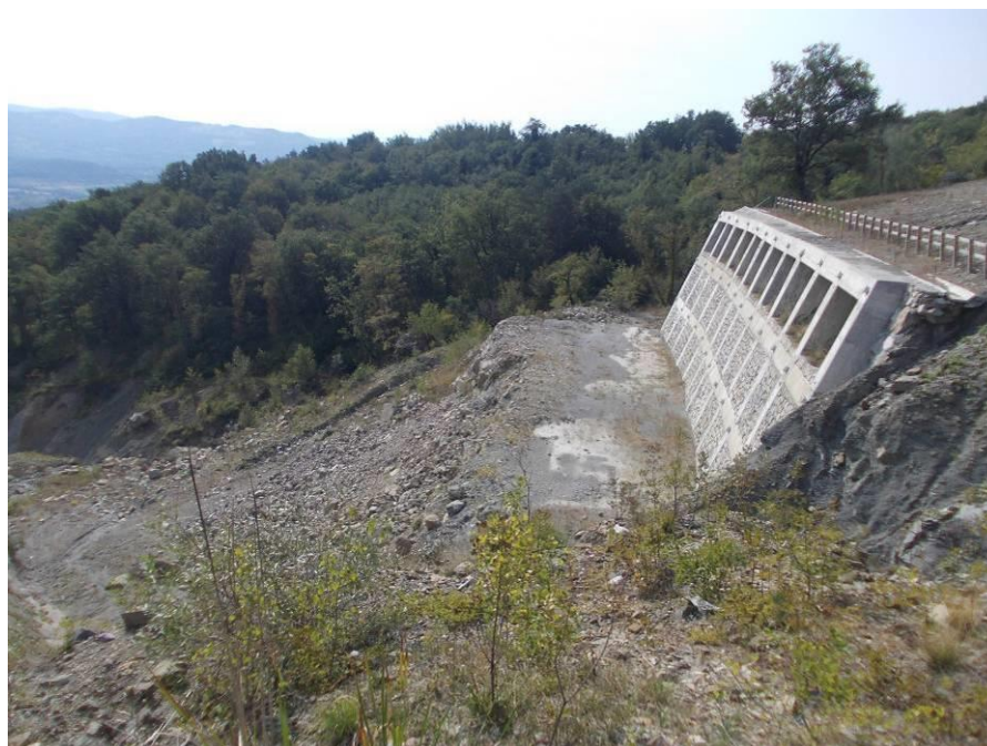
Slika 56: Delno izvedena podporna konstrukcija pod slapom (Vir: Mikec, 2011)
