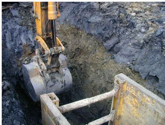
Slike 20, 21 in 22: Izdelava globoke drenaže (Vir: Fazarinc, 2003)
