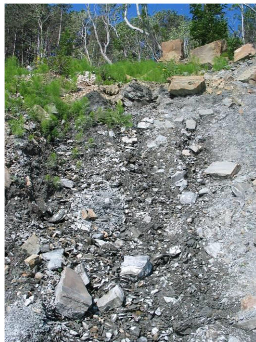
Slika 65 (desno): Poškodovana in razmočena zahodna brežina (Vir: Mikec, 2012)
