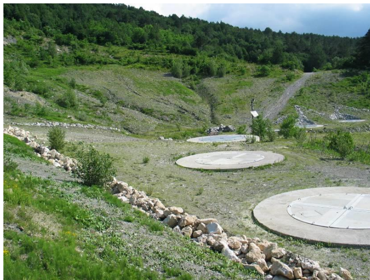
Slika 58: Kamnit material, ki preprečuje spiranje blata iz zahodne brežine v vodnjake (Vir: Mikec, 2012)
