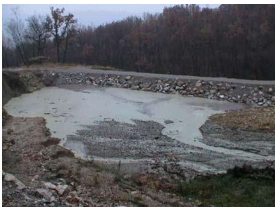
Slika 34: Kamnita pregrada za ustavitev drobirskih tokov nad vasjo Lokavec (Vir: Logar et al., 2005: str. 450)
