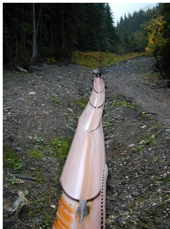
Slika 15 : Polovične PVC cevi za površinsko odvodnjo na plazu Macesnik (Vir: Fazarinc, 2003)
