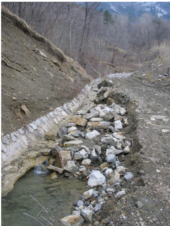
Slika 67 (levo): Poškodovan obcestni jarek na desnem boku plazu, dolvodno od stare avstrijske pregrade (Vir: Mikec, 2013)
