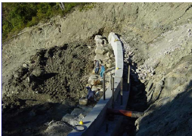
Slika 52: Sanacija stare avstrijske pregrade (Vir: arhivsko gradivo Stokovnega odbora za velike plazove)
