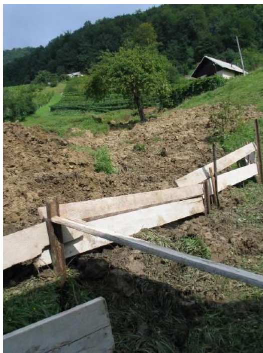
Slika 11: Lokalna preusmeritev plazine (Vir: Ribičič in sod., 2005: str. 23)
