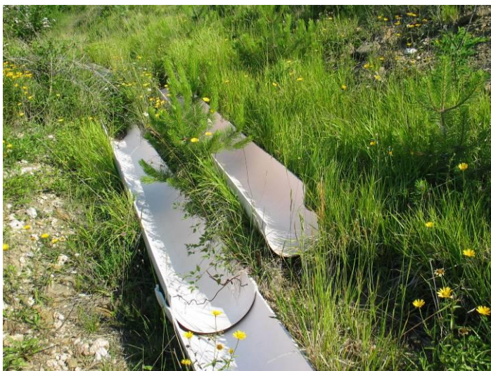
Sliki 60 in 61: Prestavljene in poškodovane polovične cevi kanala 3
