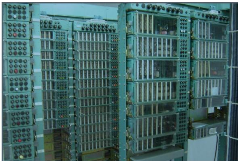
Slika 16: Stojalo z relejnimi skupinami (Romanešen, 2011)
