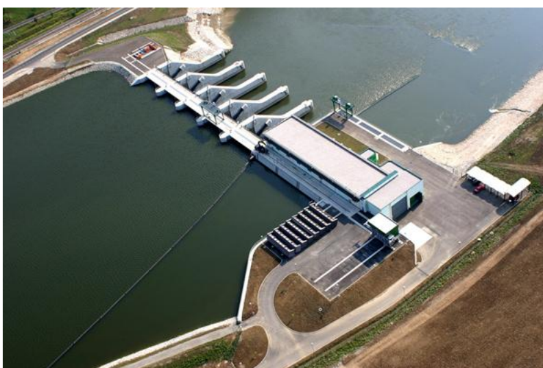
Slika 3: Hidroelektrarna Boštanj ( http://www.he-ss.si )
