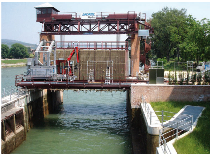
Slika 46: Primer uporabe Straflomatrix turbin (Andritz, 2012)
