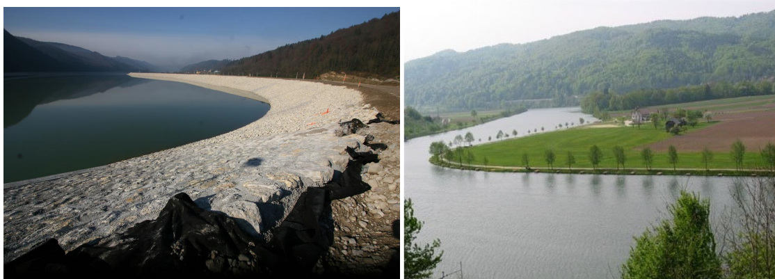
Slika 12: Primer ureditve brežin s kameno zložbo v betonu ( http://www.hess.si ) in sonaravne ureditve ( http://www.ribiska-druzina-radece.si/ )
