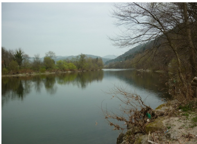
Slika 26: Ogljed terena lokacije pragu Podšentjur
