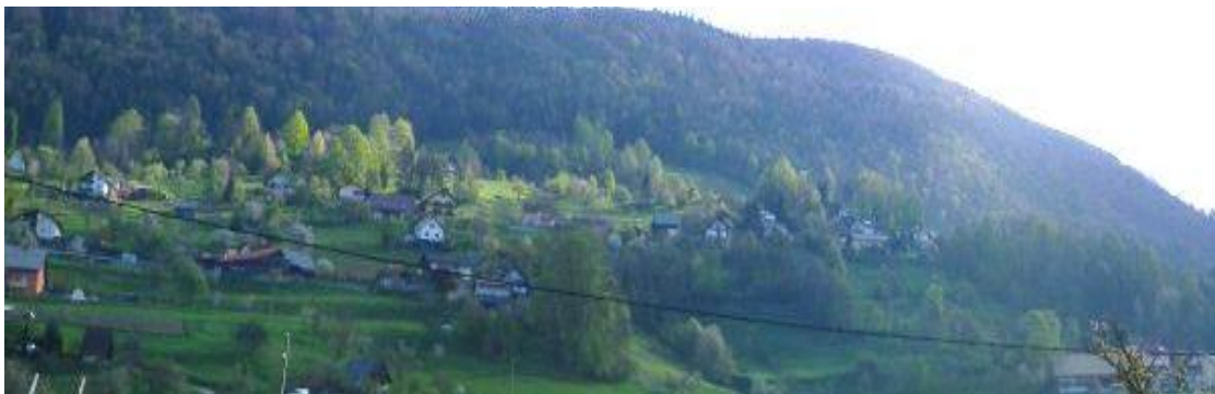
Slika 26: Obcestna gradnja na pobočju
