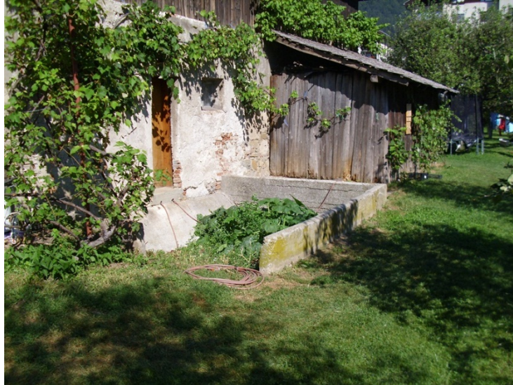
Slika 12: Gnojna jama, obdana z nizkim betonskim zidom
