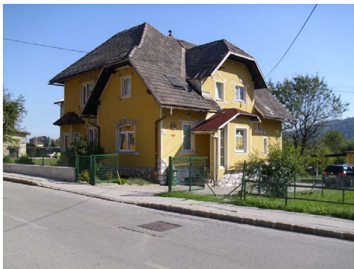
Slika 10: Mrežasta ograja in betonski zid ob dovozu na dvorišče
