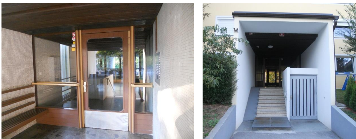
Slika 34: Vhodna vrata v blok (levo) ter vhodna vrata v klet (desno)
