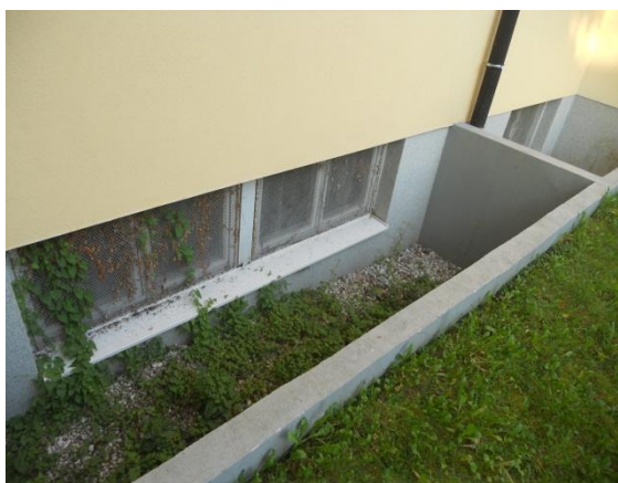
Slika 35: Kletna okna v svetlobnih jaških
