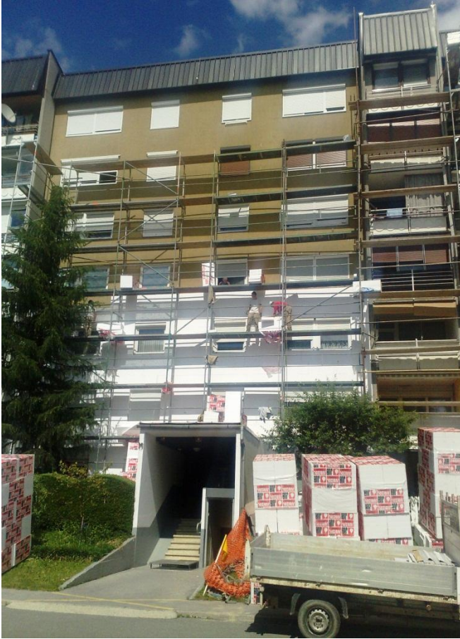
Slika 30: Pogled na zahodni del fasade med obnovo fasade poleti 2010. Delavci na odrih lepijo 10 cm debele ekspanzirane polistirenske plošče na že obstoječo fasado.
