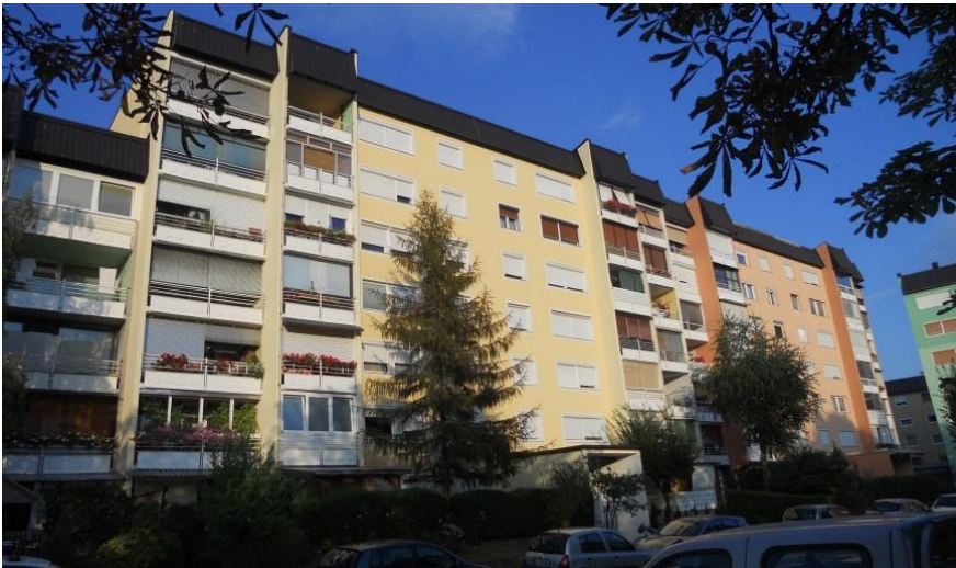
Slika 3: Pogled na zahodni del stavbe
