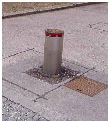
Slika 45: Avtomatski dvizni stebriček - fizična vrata, krmilnik za upravljanje stebrička Vir: Žura, M., »in sod.«, 2005, 112 (5.3.2012)
