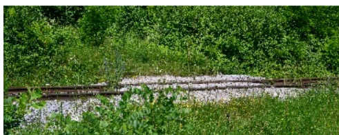
Slika 43: Pogled na opuščen NPr št. 42 Tlake
