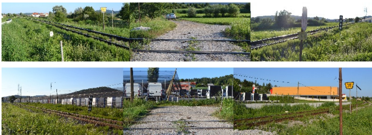
Slika 52: Pogled na NPr št. 51 Brvace v smeri vodotoka Bičje (zgoraj) in v smeri regionalne ceste (spodaj)
