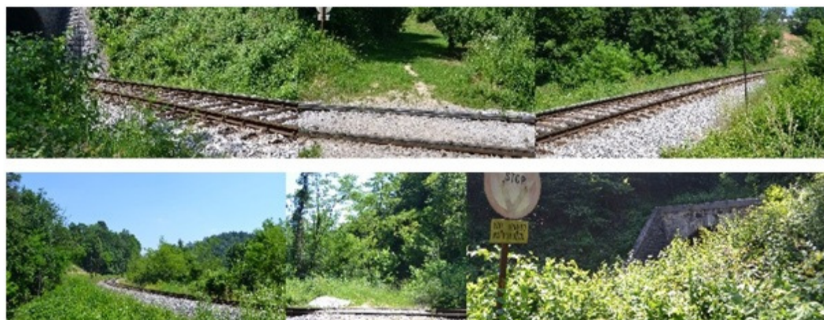
Slika 44: Pogled na NPr št. 43 Razdrto v smeri proti lokalni cesti (zgoraj) in v smeri proti gozdu (spodaj)
