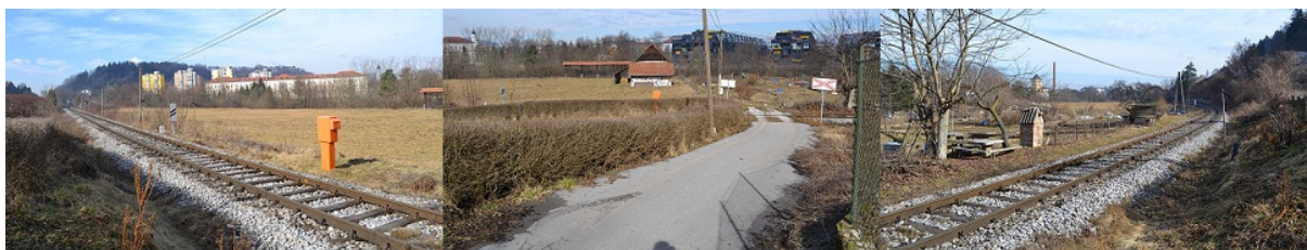
Slika 14: Pogled na NPr št. 08 Gruberjev prekop I v smeri vodnega kanala Gruberjev prekop
