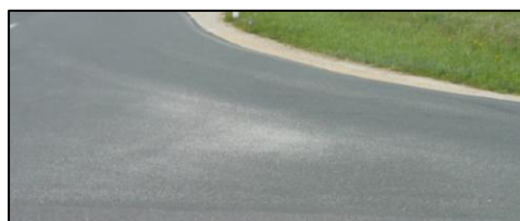
Slika 12: Zamazanost vozišča zaradi vožnje preko peščne bankine
